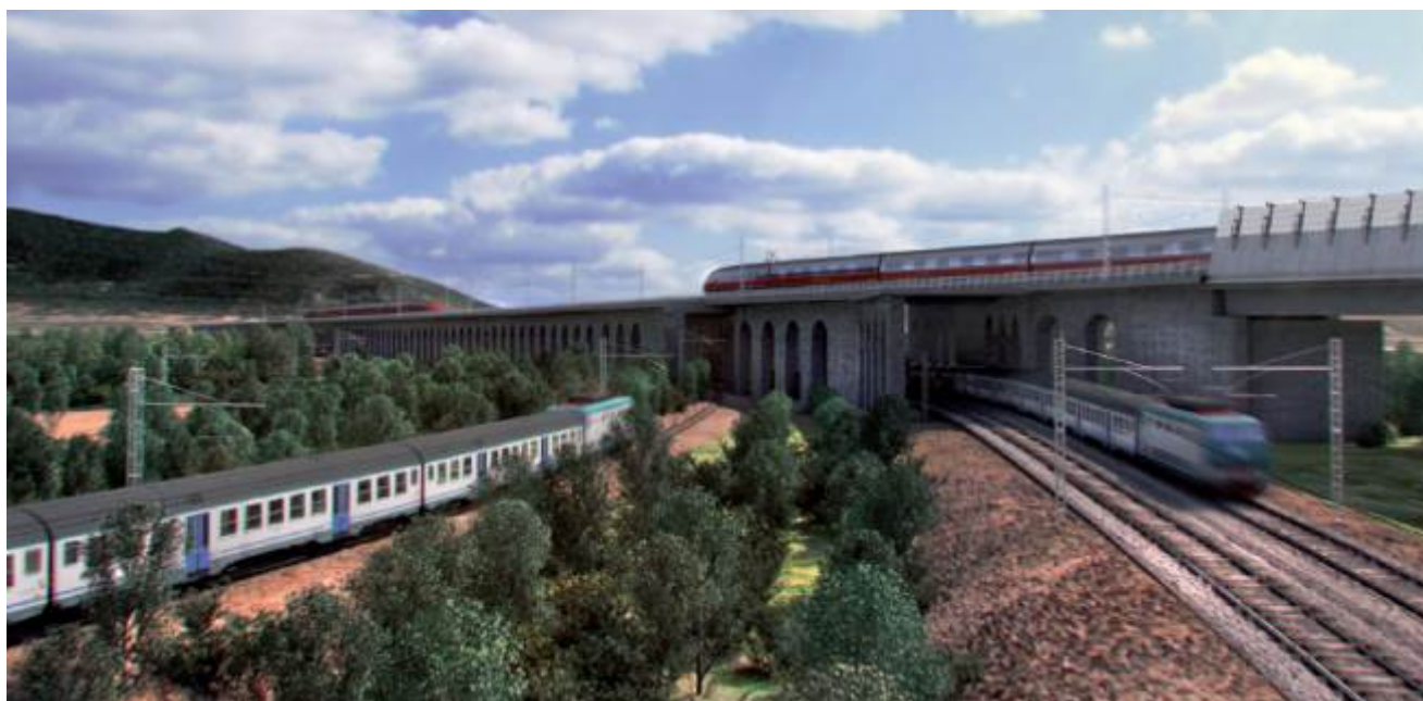
Fig. 8 – VI01 “Struttura ad archi”
