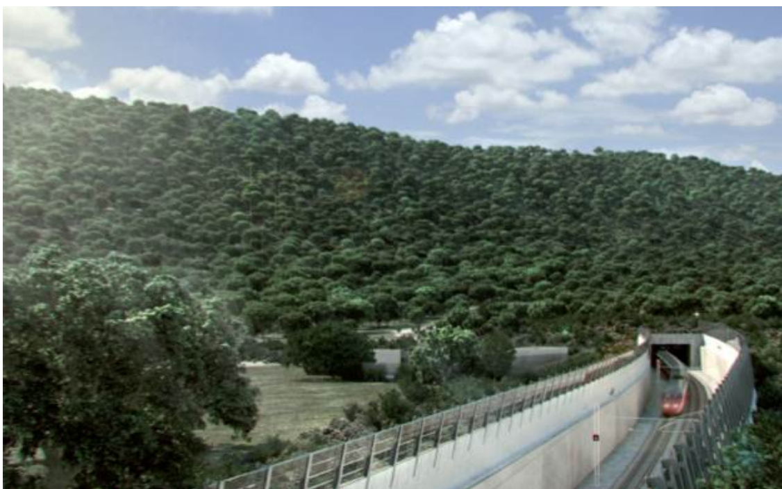
Fig. 4 – Imbocco Nord della Galleria Monte Aglio
