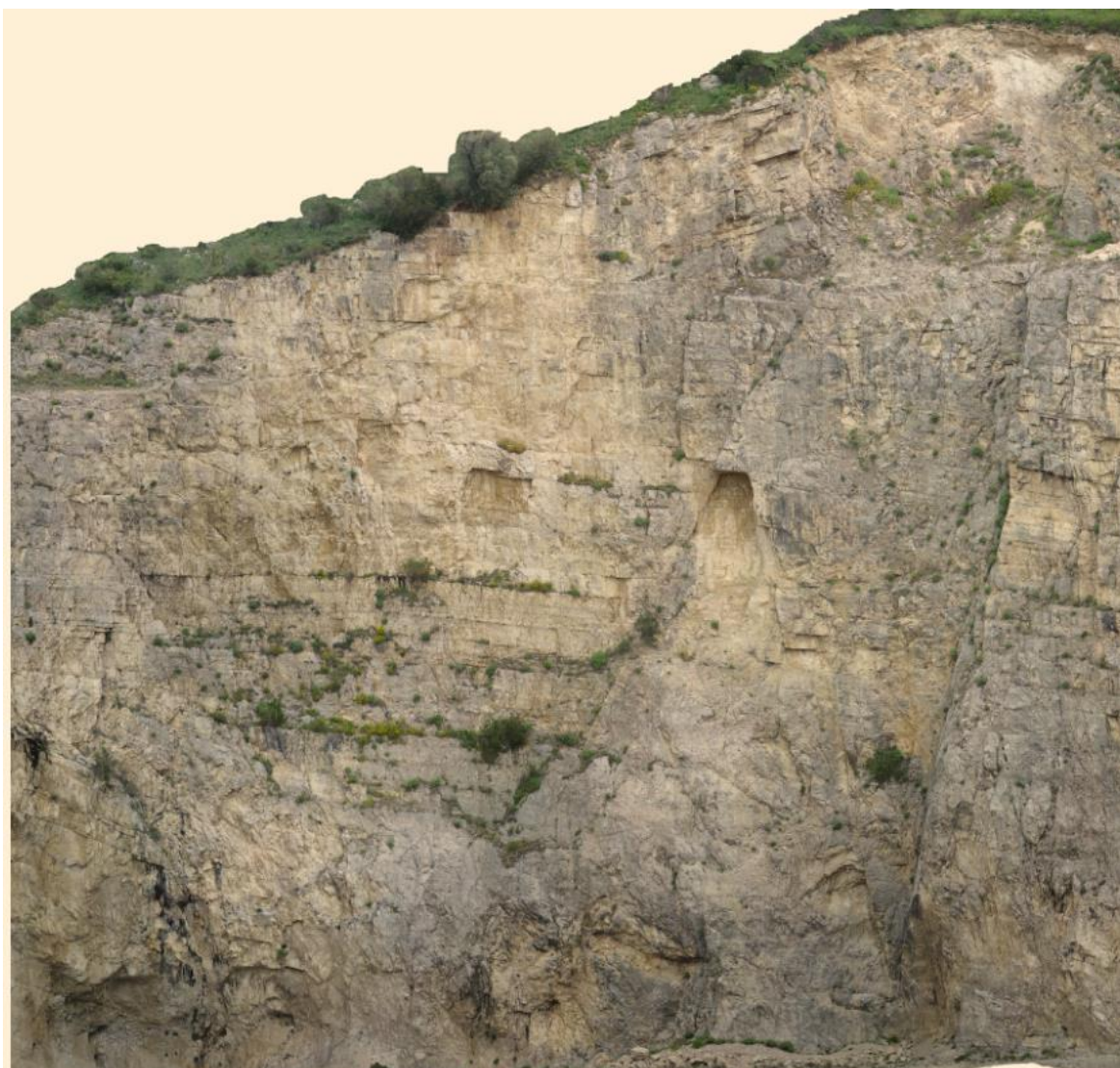
Foto 6 Ortofoto piano in prossimità dell'imbocco
