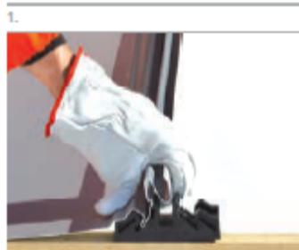
Una volta agganciata la lastra alla prima fila di staffe, posizionate la seconda fila di staffe sul lato libero della lastra (lato canale di drenaggio per Riverclack® 500 e Riverclack® 550 e lato inferiore della greca per Riverclack® Grip 600) con una semplice pressione.
