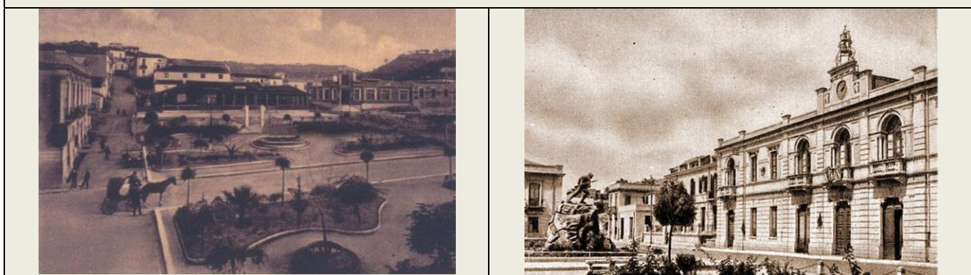
FIG. 9.1.6 - PAESAGGI INSEDIATI VILLA SAN GIOVANNI – CENTRO STORICO DOPO LA RICOSTRUZIONE
