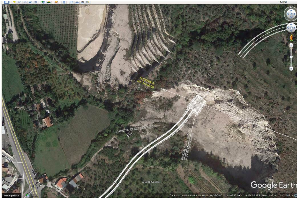
Figura 24 – Localizzazione del piazzale 3+610 km della prima uscita di emergenza.
