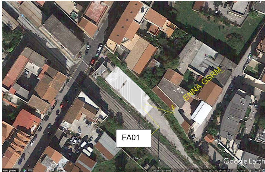
Figura 1 – Localizzazione del fabbricato FA01.
