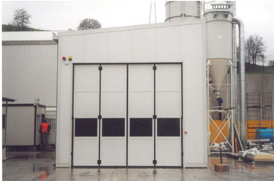
Figura 6.4 Insonorizzazione area di carico betoniere
