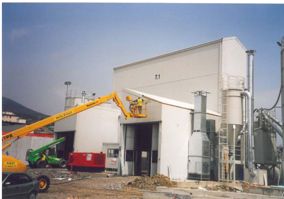
Figura 6.5 Vista complessiva impianto insonorizzato
