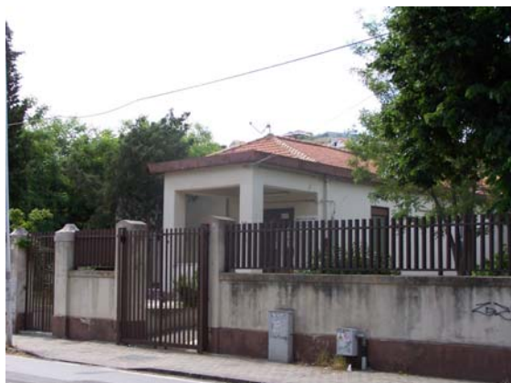
Direzione Didattica Ganzirri – Scuola Elementare
