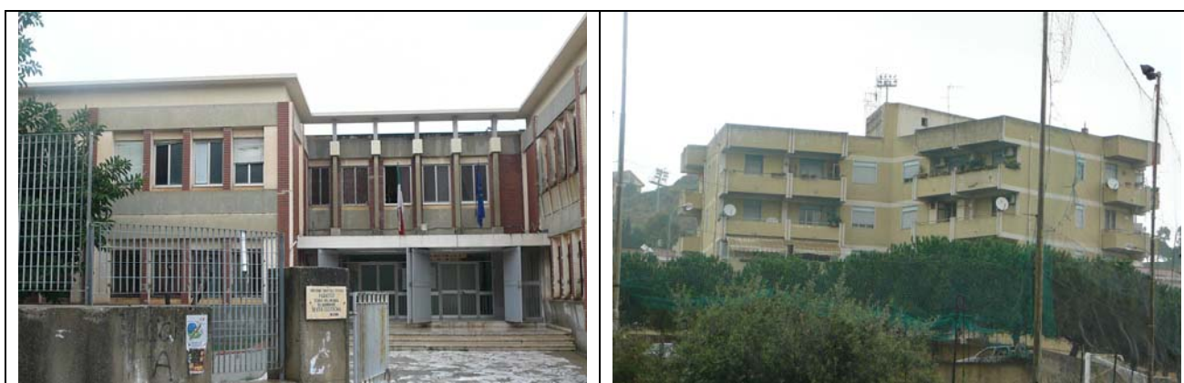
Figura 3.25 Ricettori cantiere SS2 Annunziata
