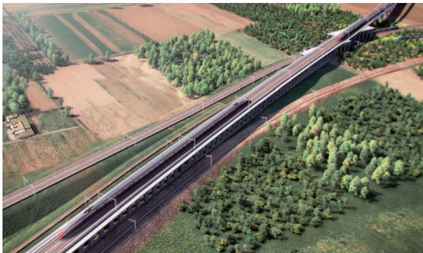
Figura 6 – Struttura ad Archi – collegamento scalo Marcianise
