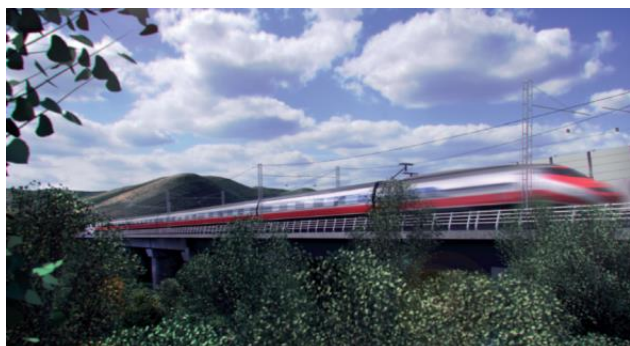
Figura 4 – VI07 Viadotto Isclero
