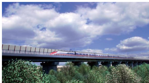
Figura 5 – VI06 Viadotto San Michele
