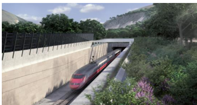
Figura 2 – Imbocco Sud della Galleria Monte Aglio
