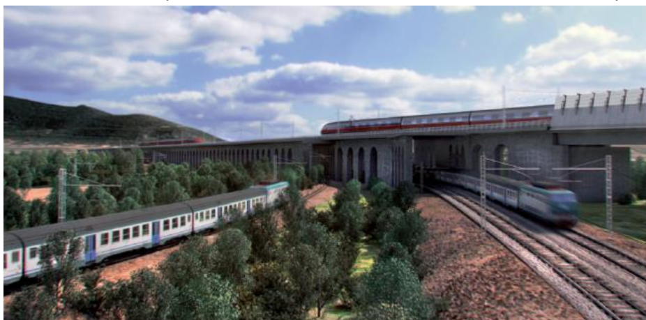
Figura 7 – VI01 "Struttura ad archi"
