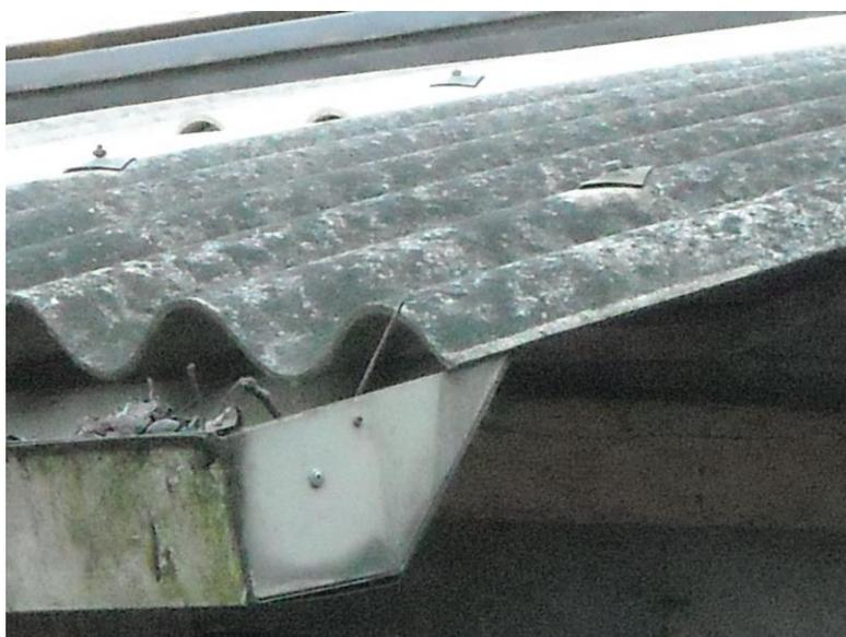
Figura 8-1: Particolare copertura amianto
