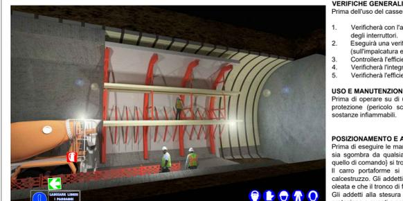
Il rivestimento definitivo viene realizzato utilizzando un apposito cassero metallico, costituito da un telaio portante su cui sono montate casseforme metalliche cilindriche. Il cassero, sostanzialmente, è composto da:
