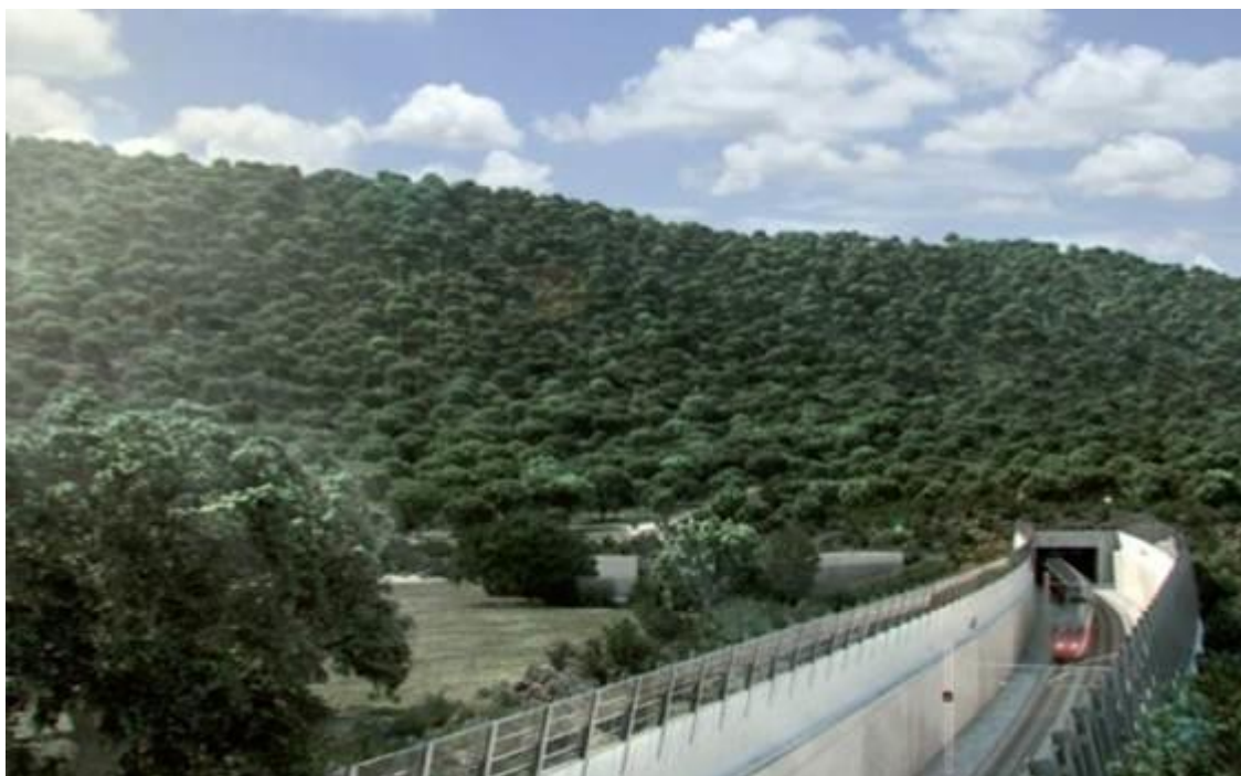
Figura 2-4: Imbocco Nord della Galleria Monte Aglio
