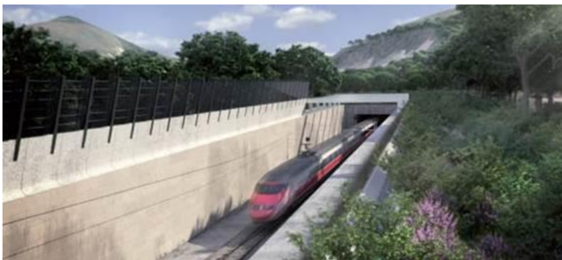
Figura 2-3: Imbocco Sud della Galleria Monte Aglio
