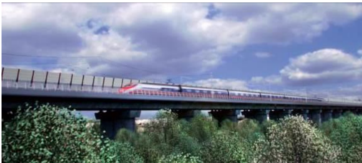
Figura 2-5: VI06 Viadotto San Michele
