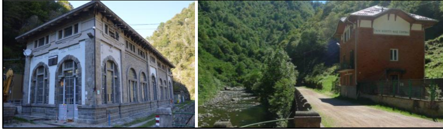
Figura 2.3.2k Centrale del Piancone e Casa addetti ai lavoratori
