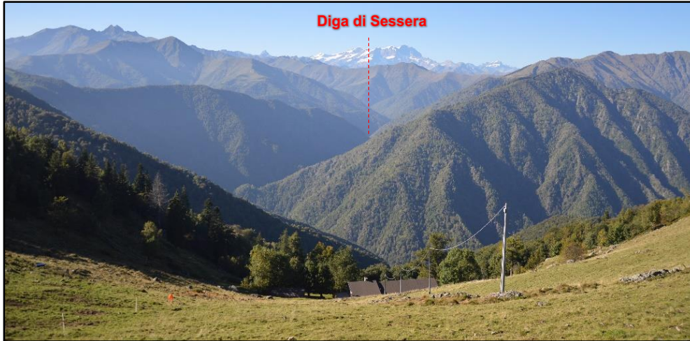
Figura 4.1.2.2b Bocchetta di Margosio – strada “Panoramica Zegna”
