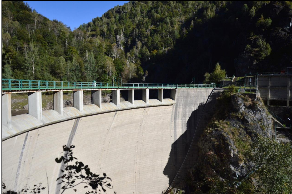
Figura 2.3.2m Diga di Sessera oggetto di intervento
