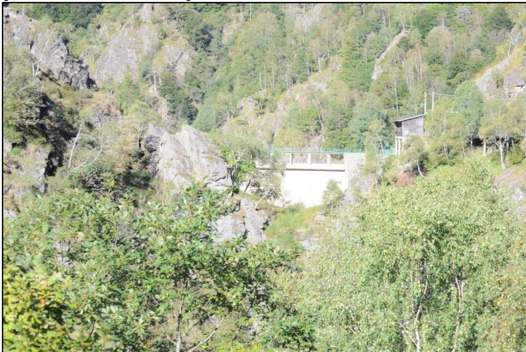
Figura 5.4a Foto 1: vista della Diga da valle
