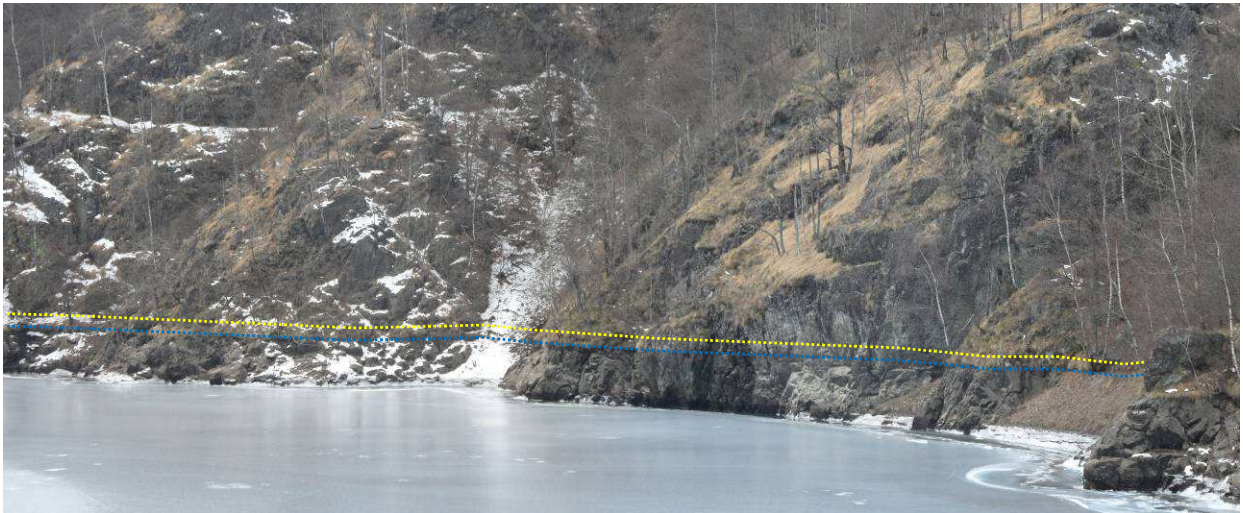
Fig. 5.2 – Panoramica dell'invaso interessante il T. Sessera. La linea blu rappresenta la quota di massimo invaso attuale (926,00 m s.m.), la linea gialla all'incirca la quota di massimo invaso da progetto (927,15 m s.m.), l'invaso è a quota 921,30 m s.m..
