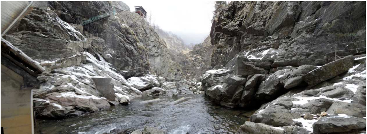
Figura. 3.1 Panoramica della zona in corrispondenza del getto al piede dello sfioratore di superficie.
