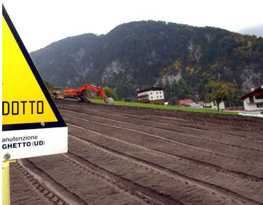
Foto 5.1/I Ridistribuzione dello strato humico superficiale
