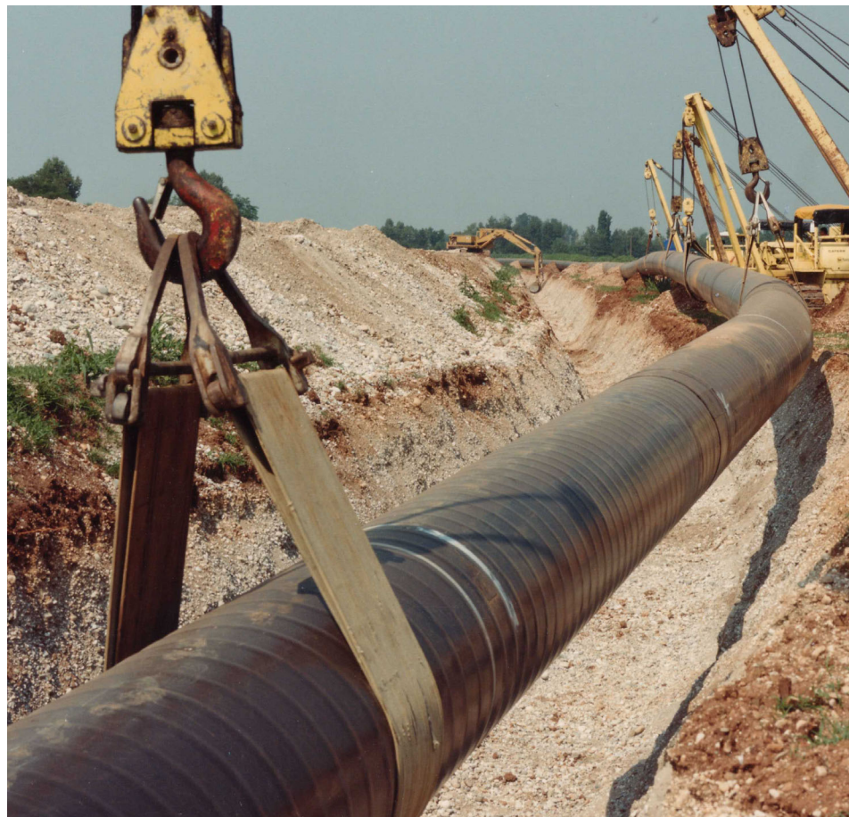
Foto 5.1/F Posa della condotta
