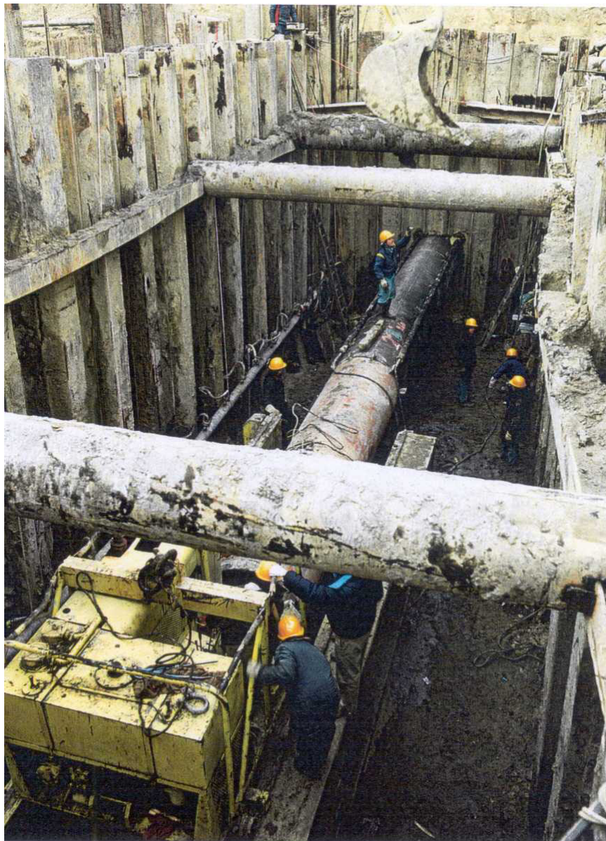
Foto 5.1/L Trivellazione con spingitubo
