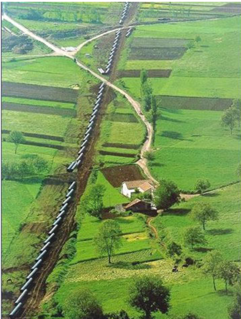
Foto 5.1/C Sfilamento tubazioni
