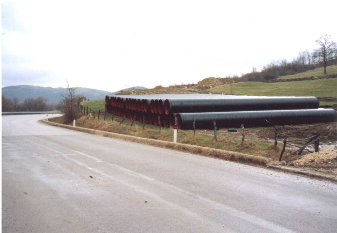
Foto 5.1/A Piazzola di accatastamento tubazioni
