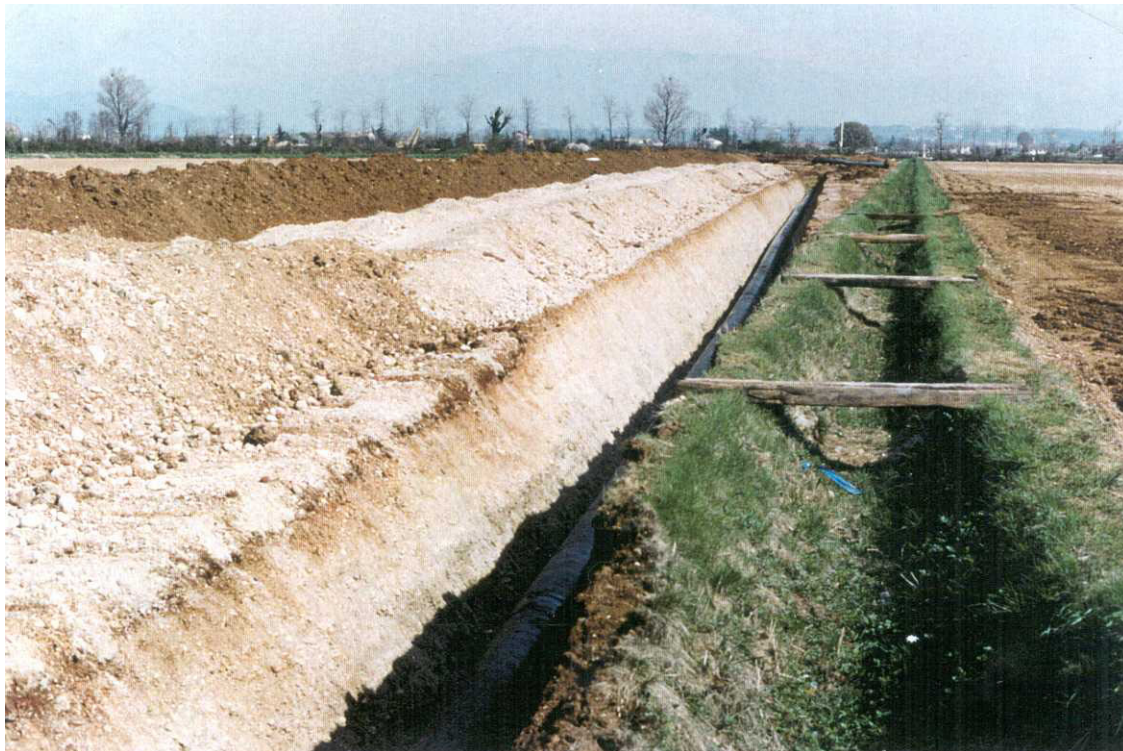
Foto 5.1/G Tratto di condotta posata, si nota l'accantonamento dello strato humico separato dal materiale di scavo della trincea
