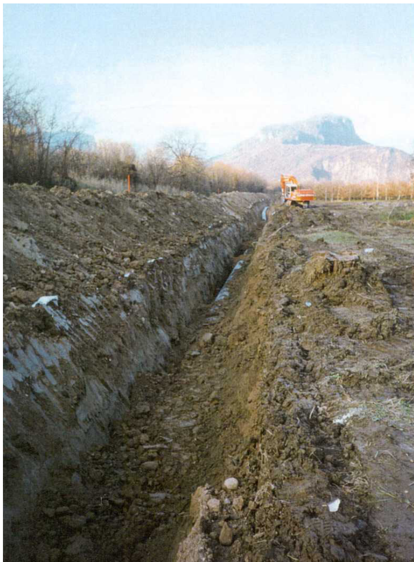
Foto 5.1/H Rinterro della condotta
