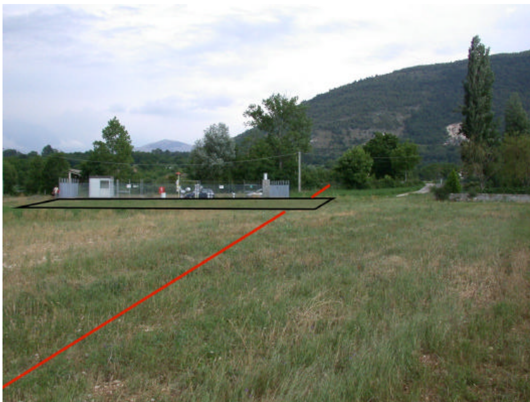
FOTO A3: PIL n. 3 Panoramica dell'area in Comune di Bugnara
