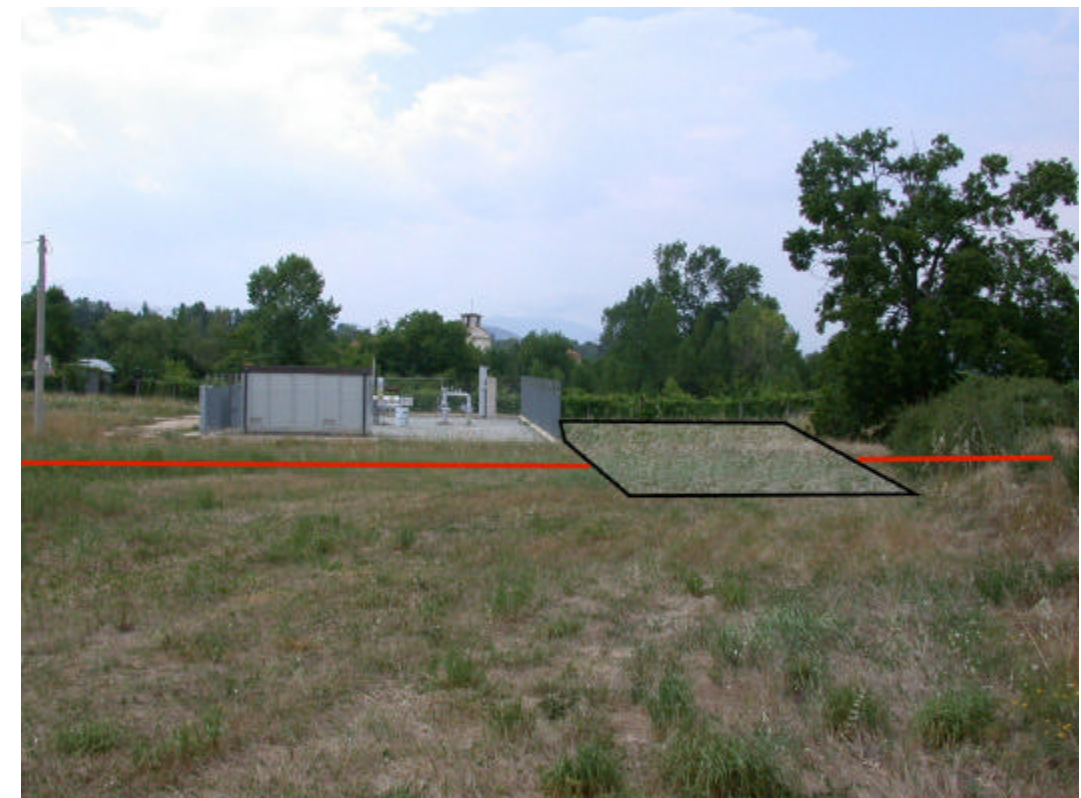
FOTO A1: PIL n. 1 Panoramica dell'area in Comune di Sulmona
