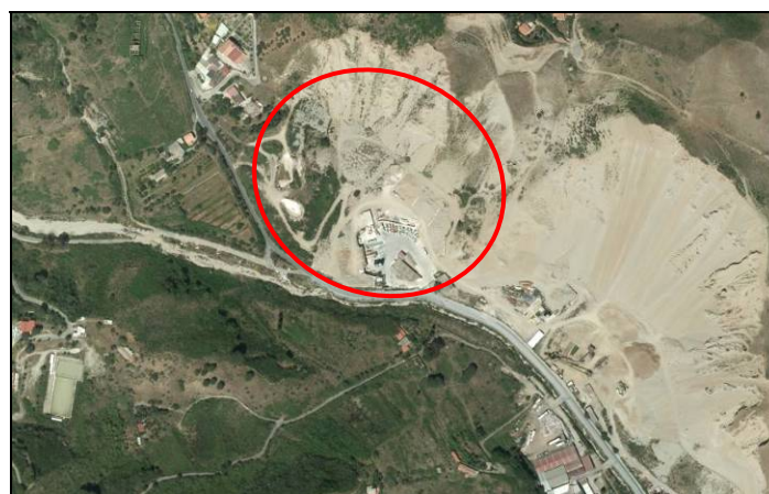
Figura 6.3 - Sito SRAS – Inquadramento su ortofoto
