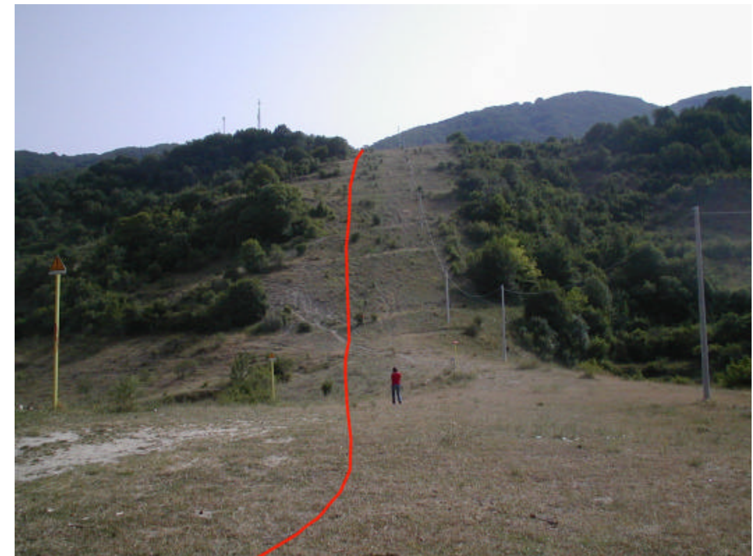
FOTO T4: Panoramica del tratto iniziale risalita in località Principio
