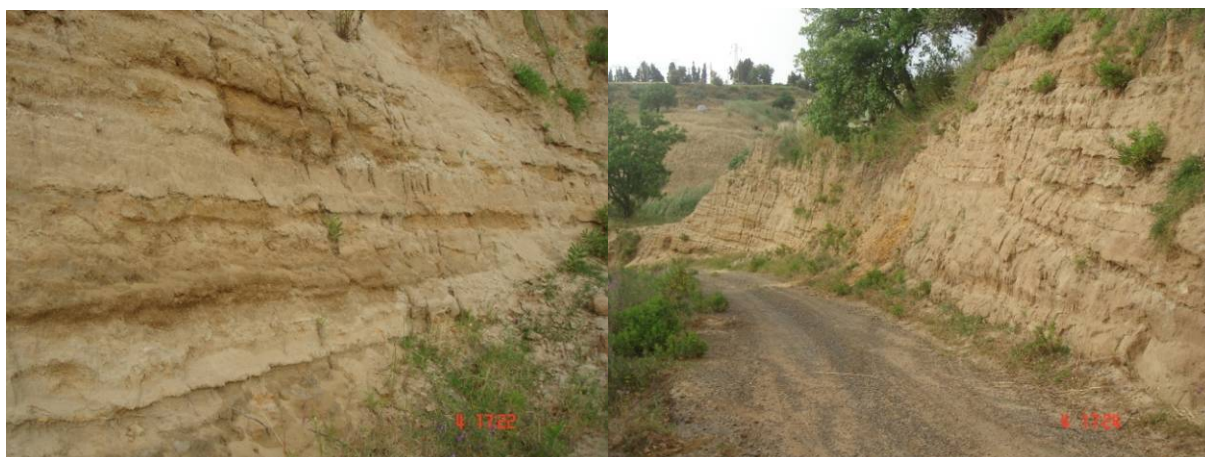
Figura 2.5.1.44 – Pareti di trincea artificiale realizzate nei depositi dei terrazzi marini presso Campo Piale.
