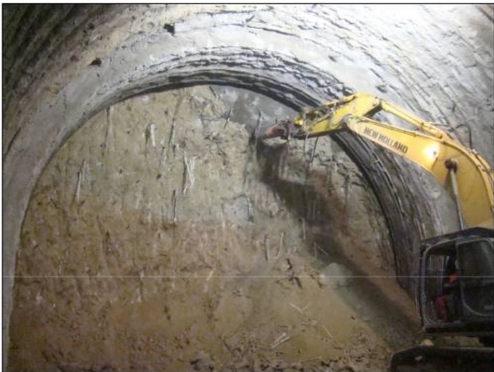
Visione fronte di scavo galleria Piale, imbocco Sud carr. Nord
