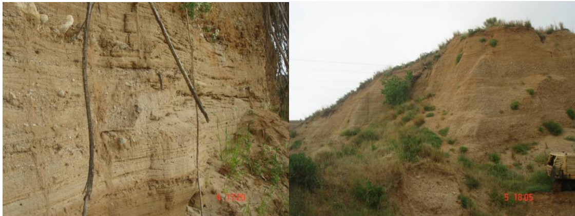
Fig. 3.27 - Affioramento in parete sub-verticale delle Sabbie e Ghiaie di Messina. Nella foto a sinistra è osservabile la stratificazione incrociata.
