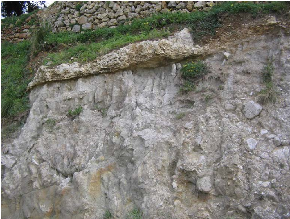
Fig. 3.15 - Affioramento del contatto trasgressivo tra la facies marnosa (Trubi (a) in legenda delle carte geologiche) e quella calcarenitica dei Trubi (Trubi (b) in legenda delle carte geologiche) a nord della stazione di servizio autostradale.
