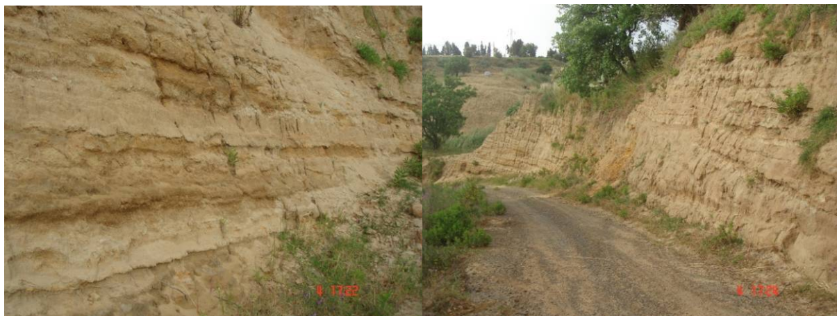
Fig. 3.32 - Pareti di trincea artificiale realizzate nei depositi dei terrazzi marini presso Campo Piale.
