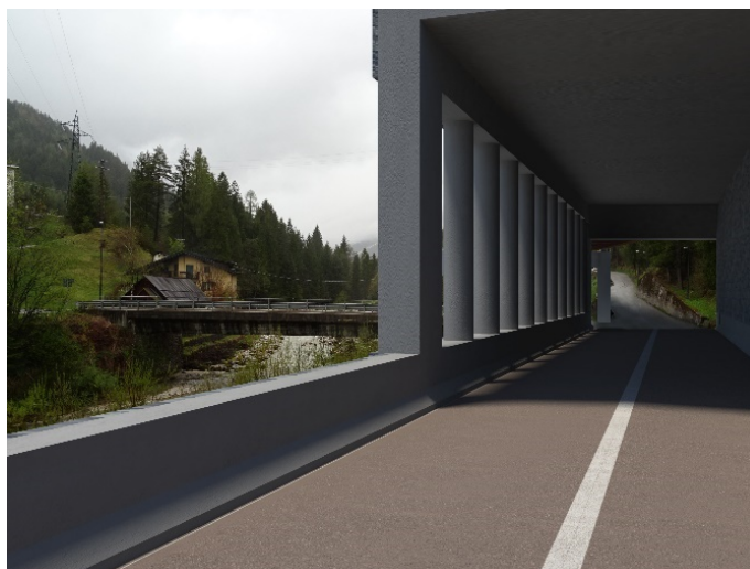
Fotoinserimento 3: Lo scatolare sfinestrato che funge anche da spalla del viadotto visto dall'interno di Via Senes visto
