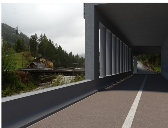
Fotoinserimento 3: Lo scatolare sfinestrato che funge anche da spalla del viadotto visto dall'interno di Via Senes visto
