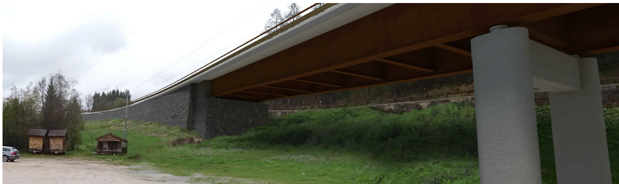
Fotoinserimento 4: La zona sottostante il viadotto in corrispondenza del parcheggio della zona artigianale.
