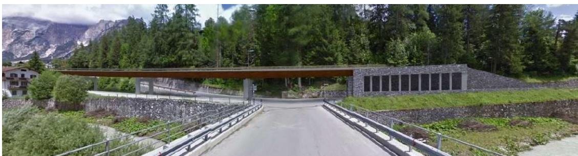
Figura 2.2 - Il viadotto di scavalco della Via Senes visto dalla strada per Serdes in corrispondenza del ponte esistente sul Boite.
