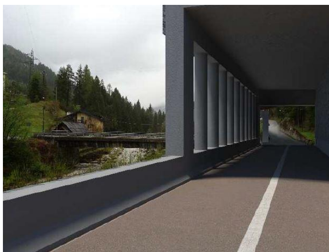
Figura 3.3 - Lo scatolare sfinestrato che funge anche da spalla del viadotto visto dall'interno di Via Senes.
