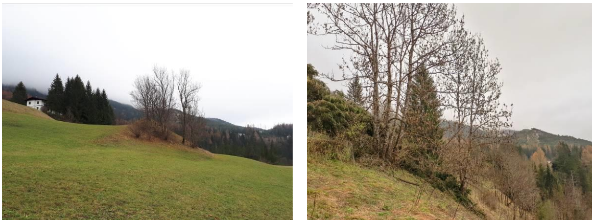
Foto 2.4 – Inclusi boscati nella zona dove verrà realizzata la galleria artificiale GA4.
