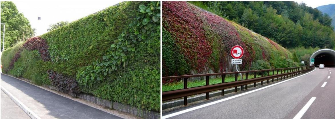
Fig. 25 e 26 Esempi di barriere acustiche e superfici artificiali rivestite da rampicanti e arbusti
