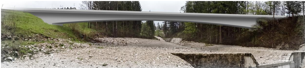
Fig. 2.3 – Ponte sul Ru Sec
