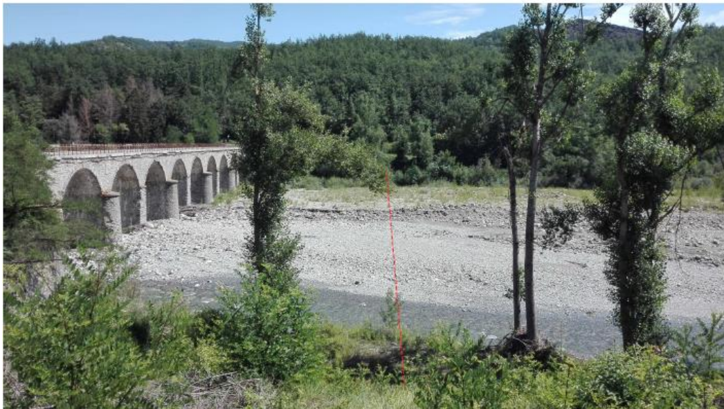
Figure: inquadramento fotografico delle aree con attraversamenti aerei e by-pass c/o Ponte Cantoniera
