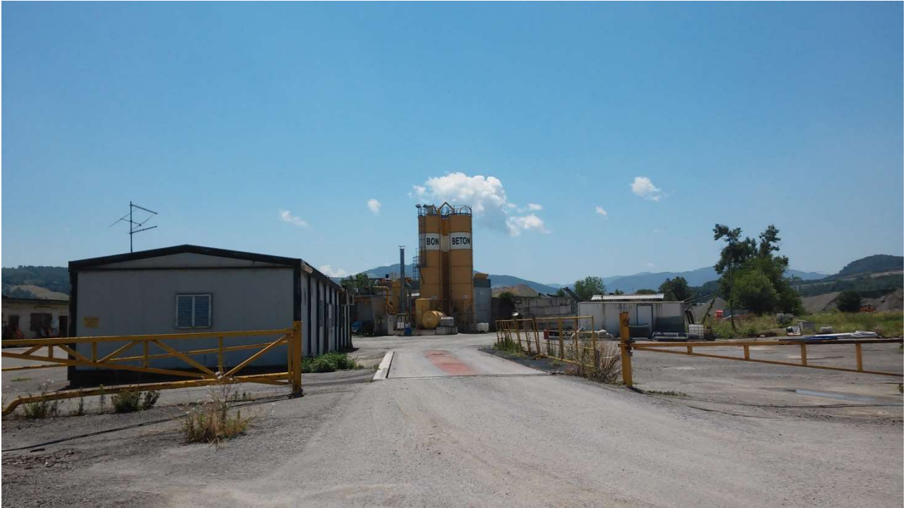
6_vista di un'area di lavorazione e estrazione in prossimità dell'alveo del Nure e del passaggio del nuovo acquedotto (Comune di Vigolzone)
