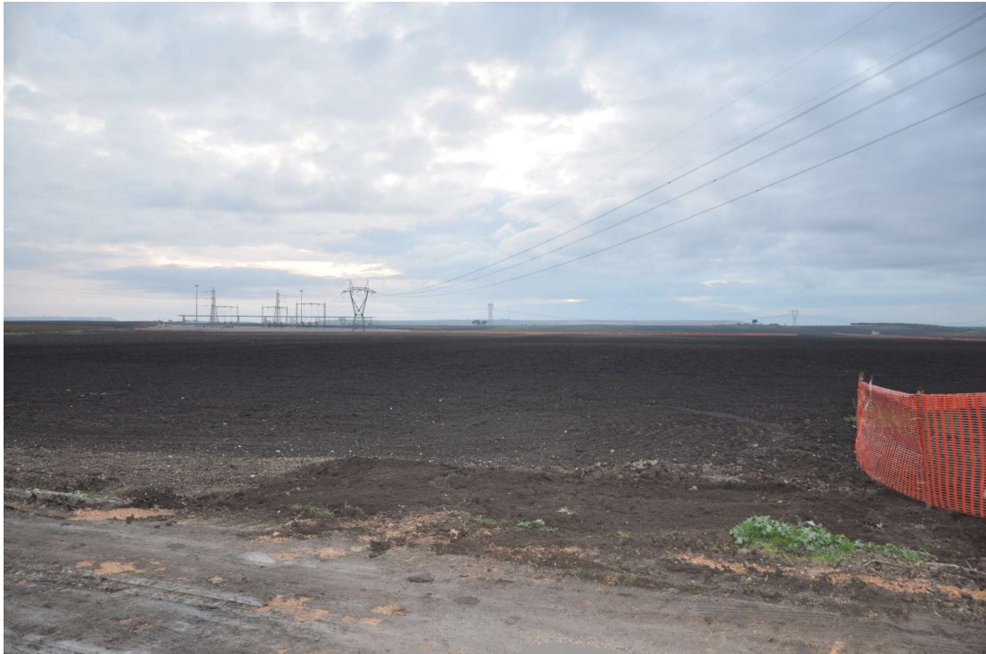
FOTO 15 – Area sottostazione elettrica utente
