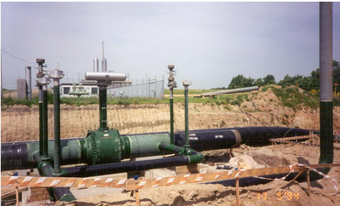
**Foto 4.1/N: Impianto di intercettazione di linea (PIL)**
