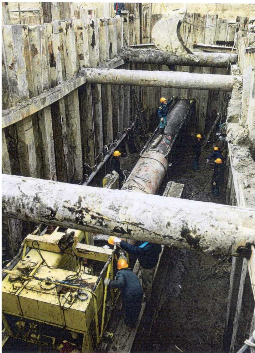
**Foto 4.1/L: Trivellazione con spingitubo**
