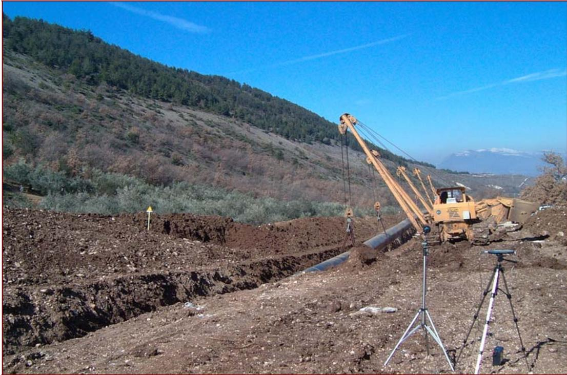
**Foto 2.2/A: Rilievi acustici durante l'operazione di posa della condotta**
