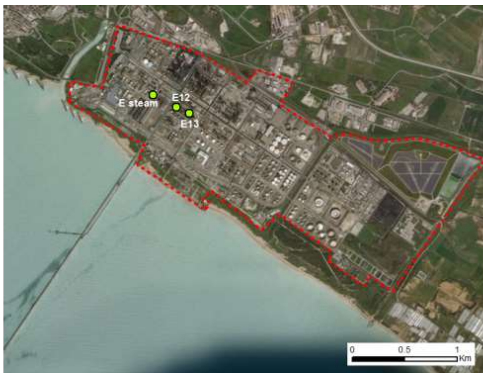
Figura 5-3 Localizzazione dei camini
