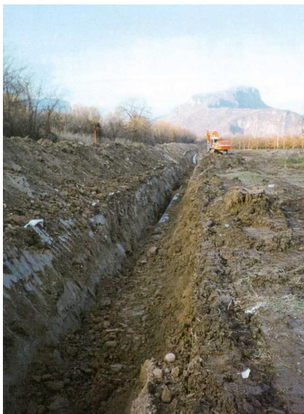
Fig. 2.9 - Operazione di rinterro della condotta.
