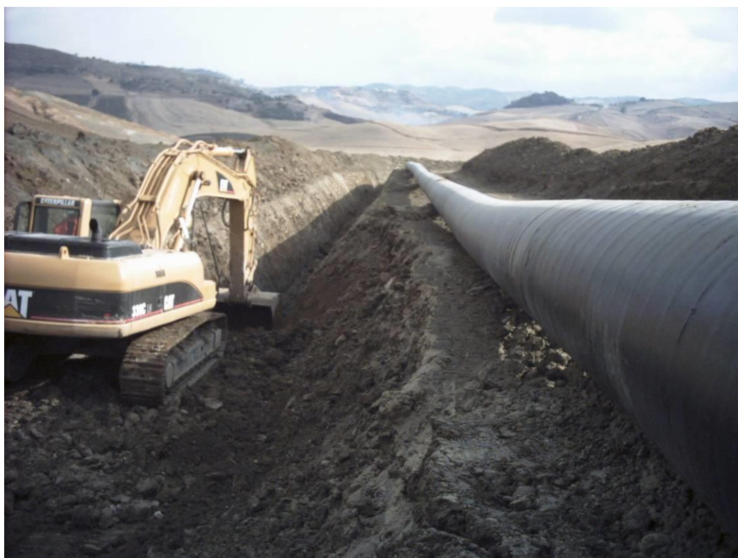
Fig. 2.7 - Scavo per l'alloggiamento della condotta.
