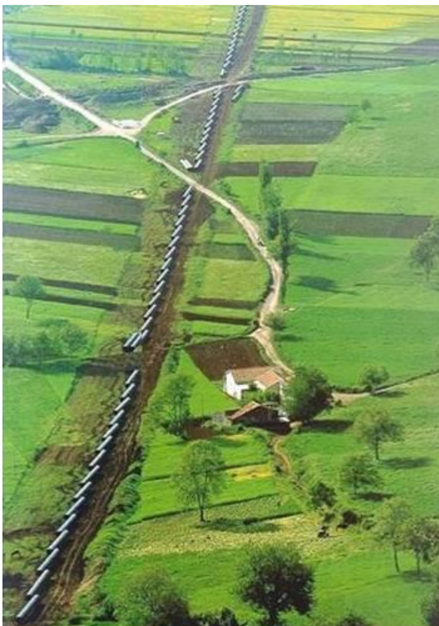
Fig. 2.5 - Sfilamento dei tubi lungo la linea.
