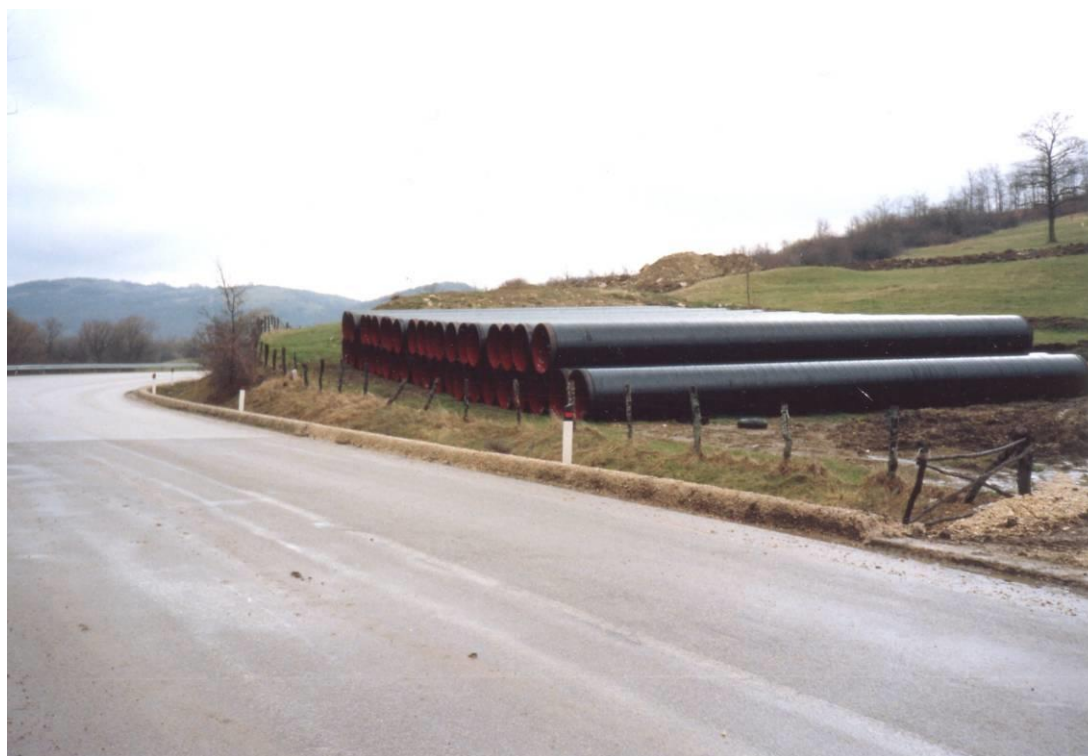
Fig. 2.4 - Piazzole di accatastamento tubazioni.
