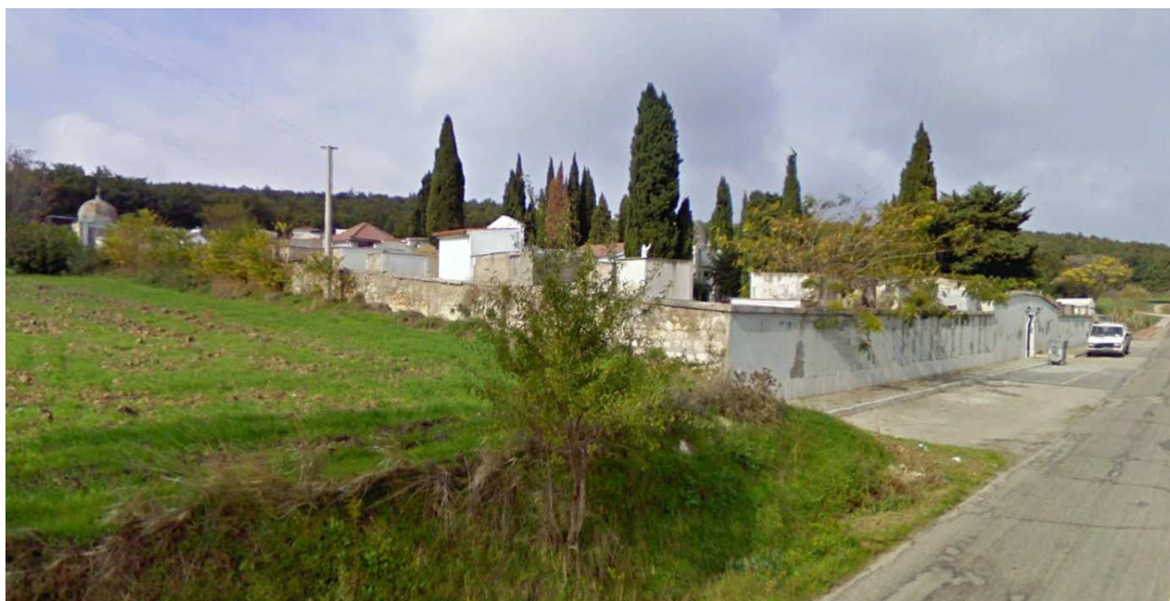
Fig. 2.22 - Lato di ingresso al cimitero di Montecilfone; sul retro è previsto il passaggio della nuova condotta
