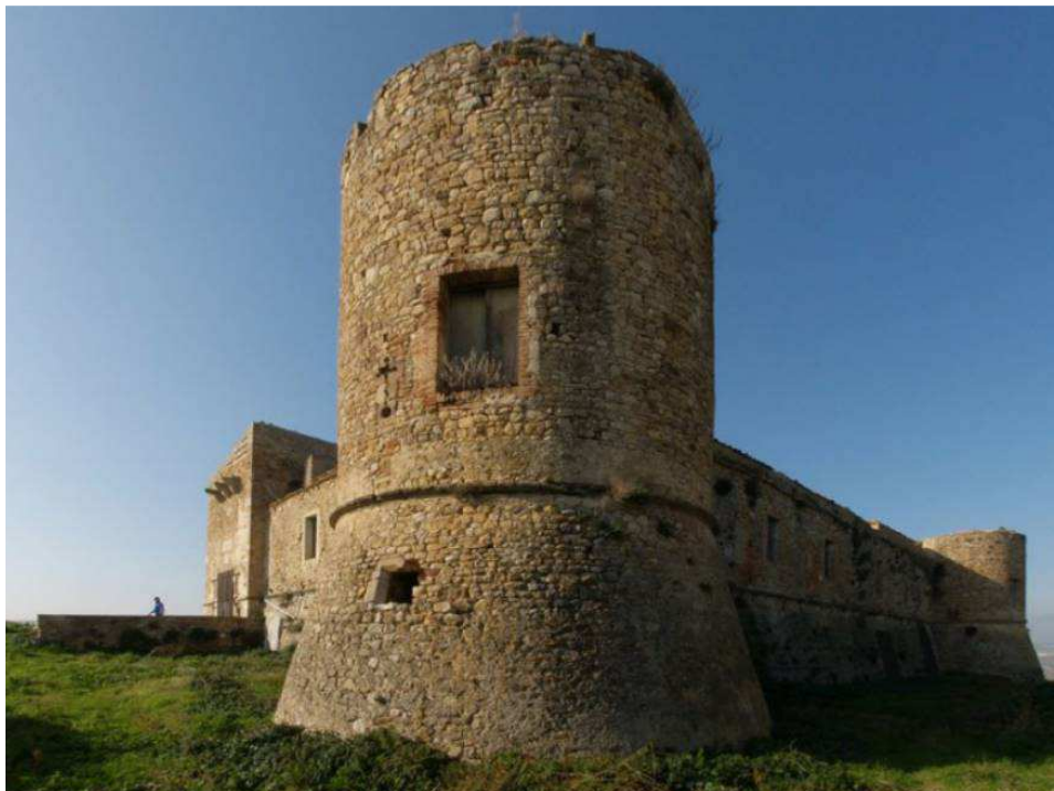
Fig. 2.26 - Resti del castello di Dragonara a più di 2km dal tracciato in corrispondenza della progressiva km 58+000 circa
