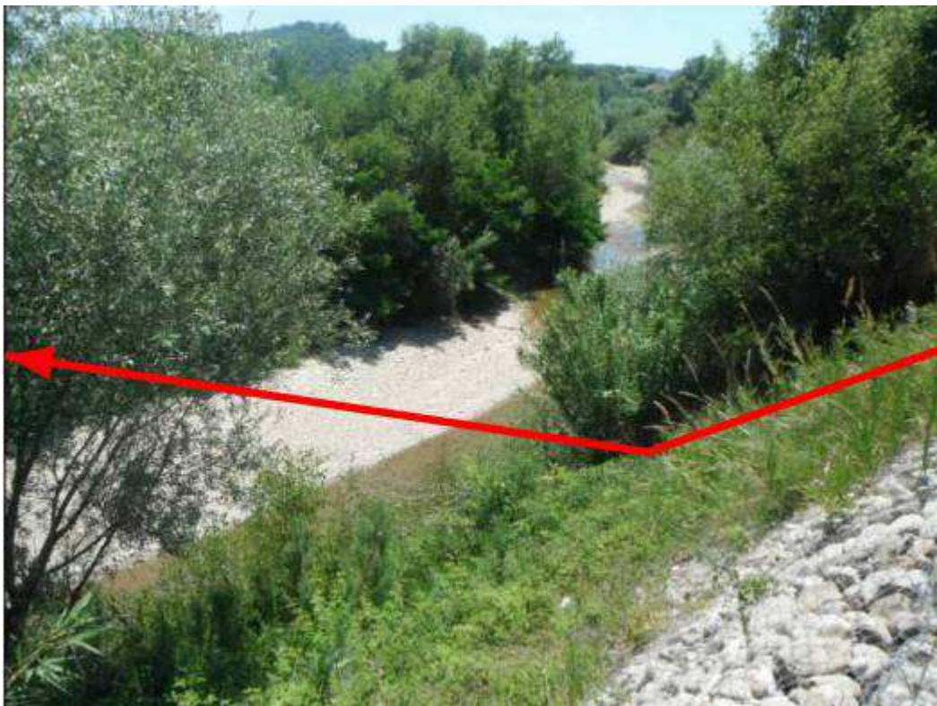
Fig. 4.3 - Attraversamento Fiume Treste
