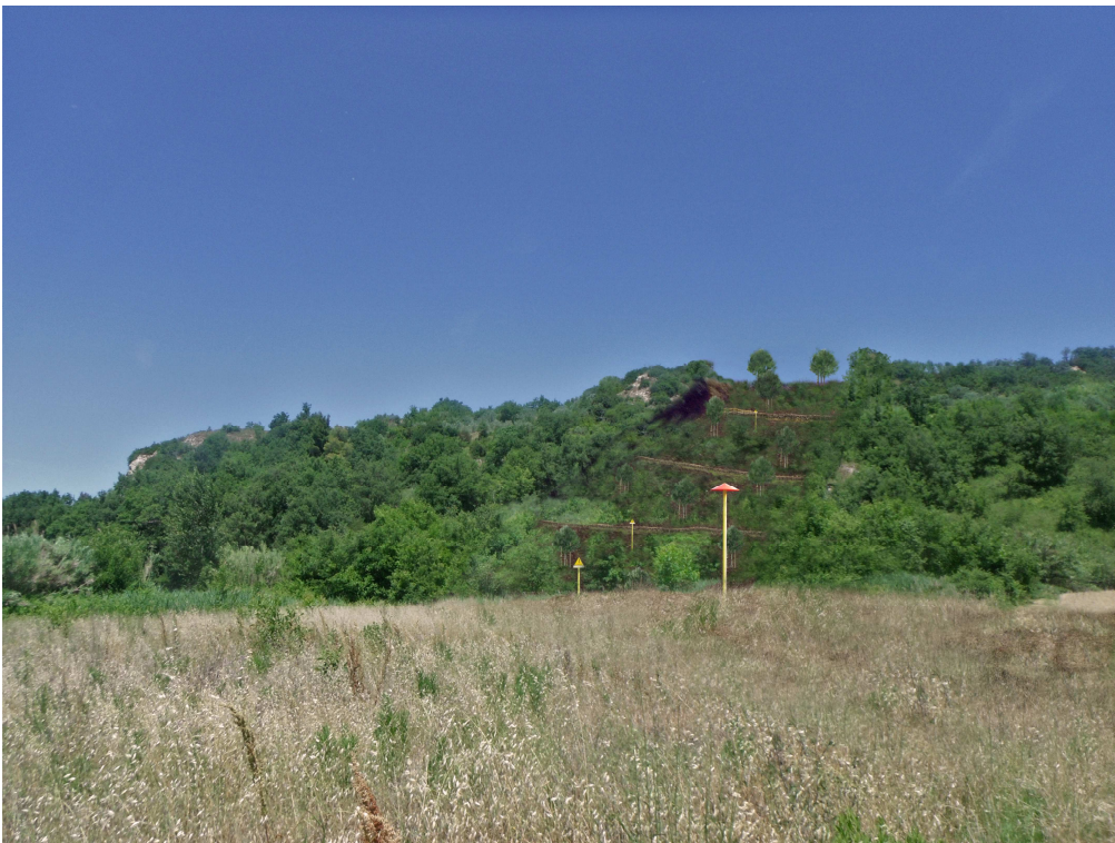
Fig. 4.43 - Affrancamento dei ripristini a distanza di alcuni anni dal termine delle lavorazioni.
