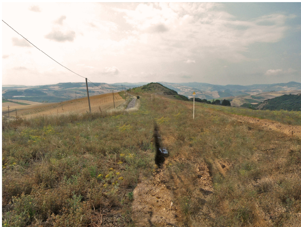
Fig. 4.39 - Termine dei lavori. Ripristini morfologici ed inerbimento eseguiti. Rimangono fuori terra solo i cartelli segnalatori.
