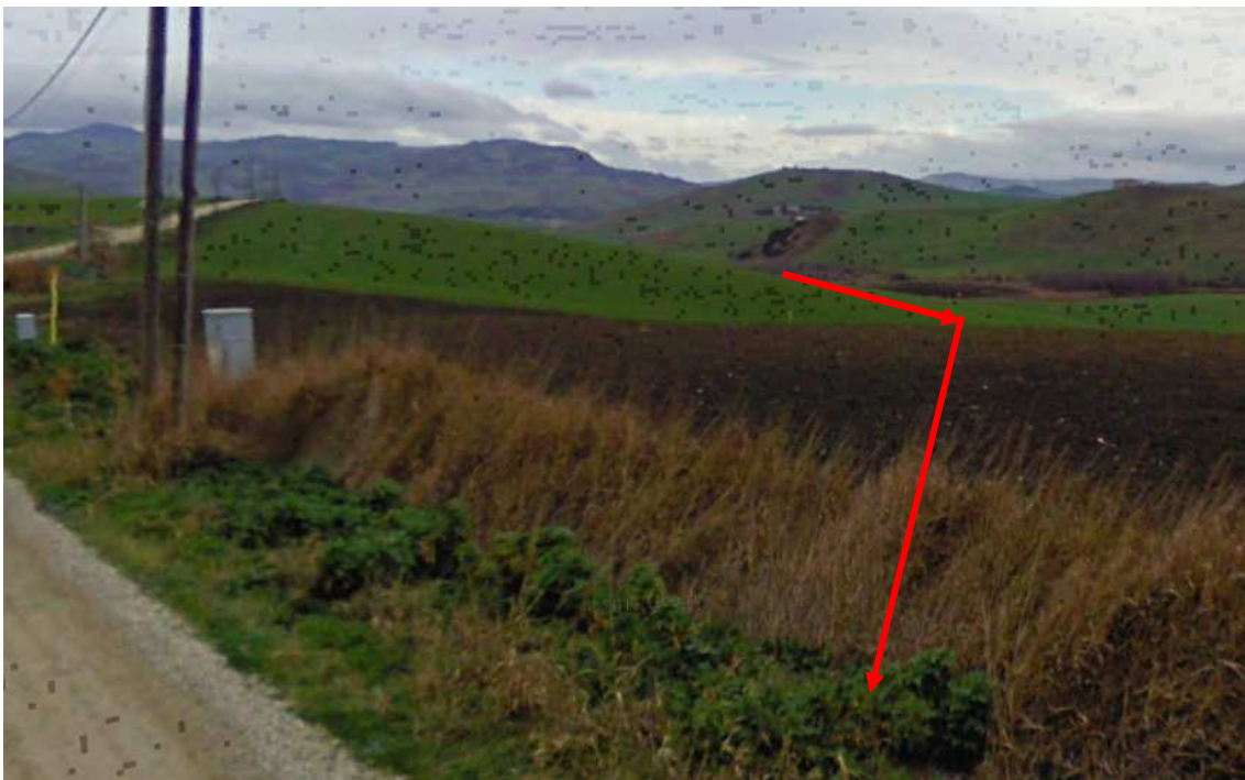
Fig. 2.11 - All'interno dell'area SIC IT7222212 – Colle Gessario la condotta attraversa i seminativi
