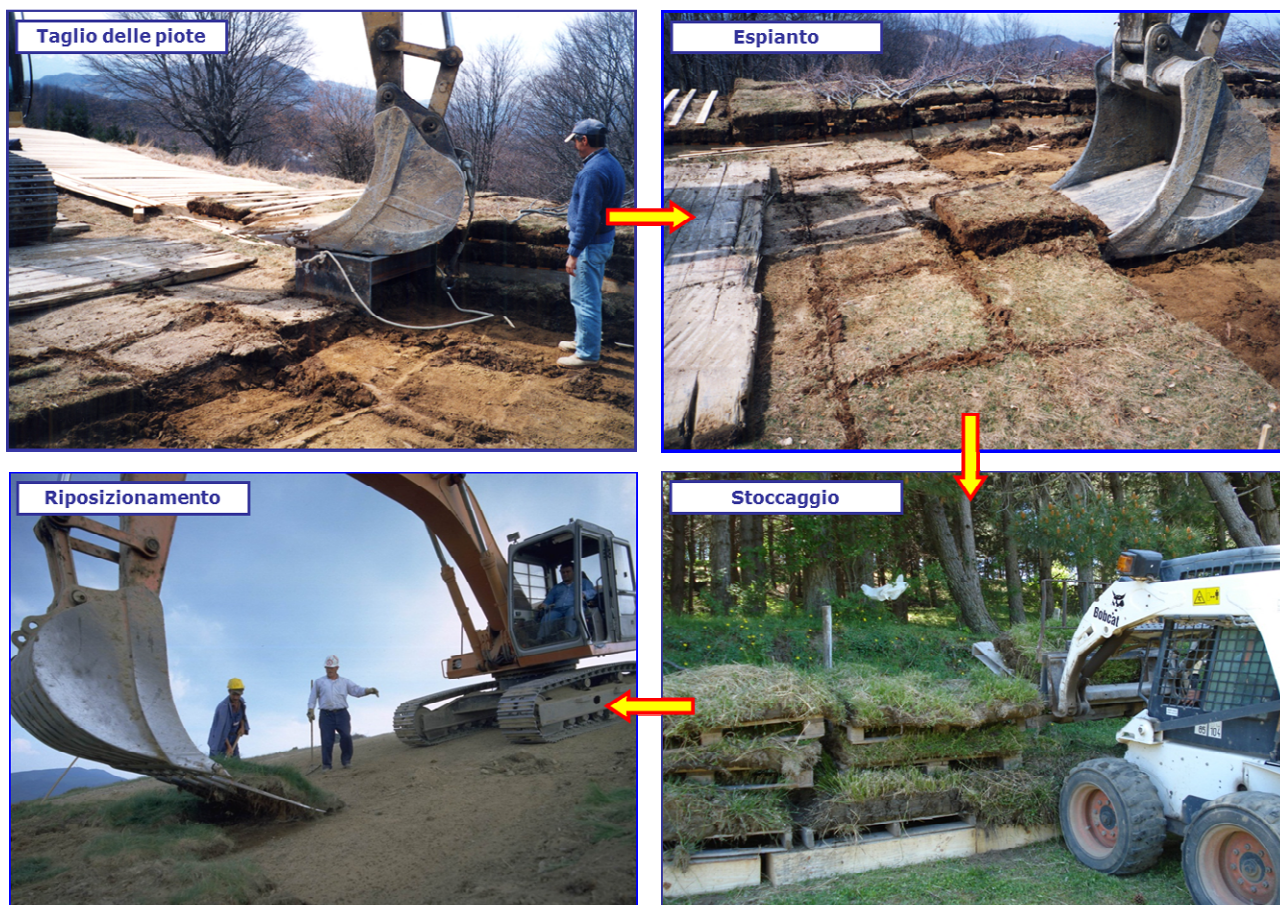
Fig. 5.13 - Fasi di taglio, espianato, conservazione e riposizionamento di zolle.
