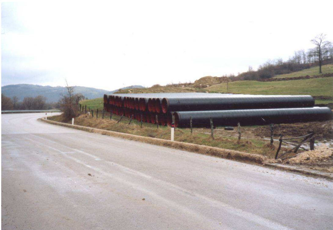
Fig. 5.1 - Piazzole di accatastamento tubazioni.
