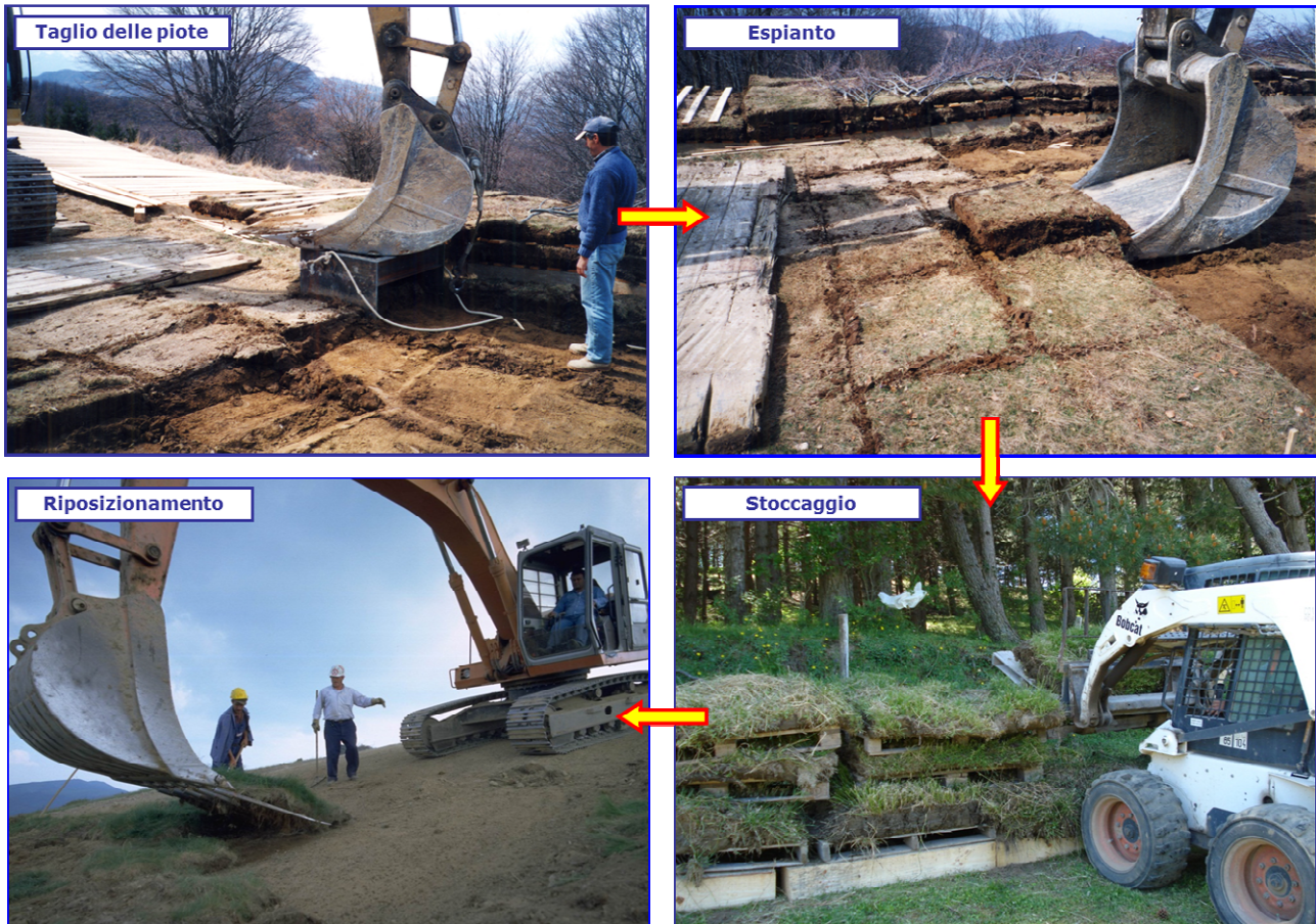
Fig. 8.13 - Fasi di taglio, espianato, conservazione e riposizionamento di zolle.
