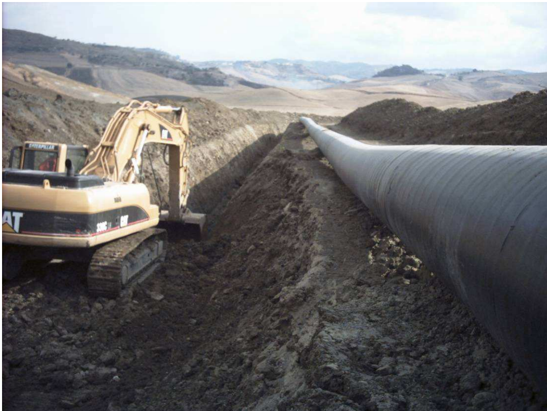
Fig. 5.4 - Scavo per l'alloggiamento della condotta.
