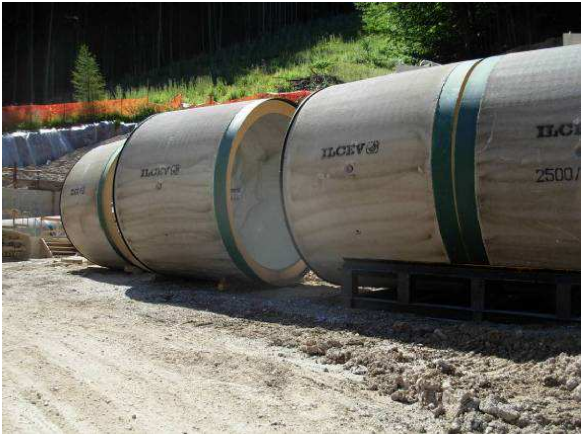
Fig. 5.15 - Stoccaggio tubi in c.a.
