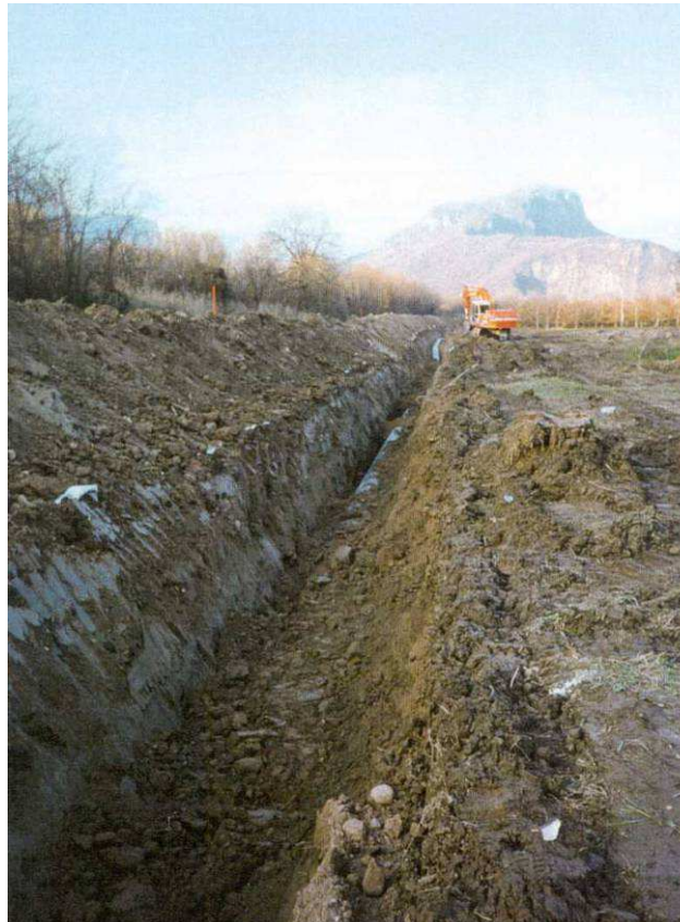
Fig. 5.6 - Operazione di rinterro della condotta.
