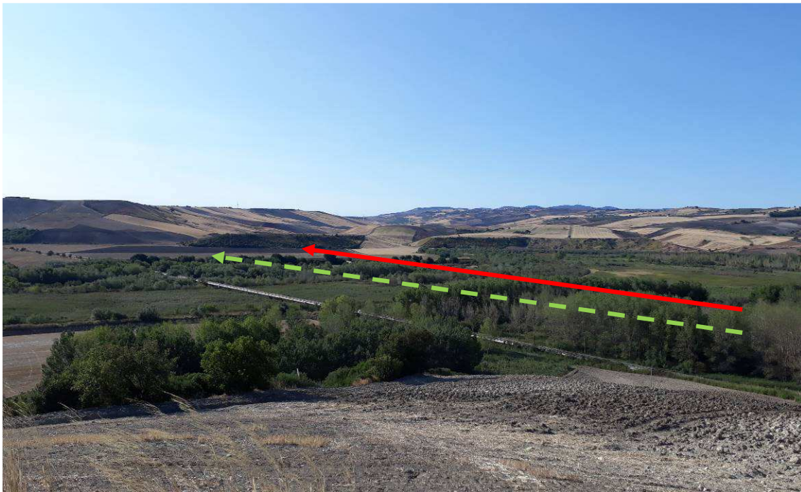
Fig. 1.36 - Attraversamento del Fortore (km 57+400).
