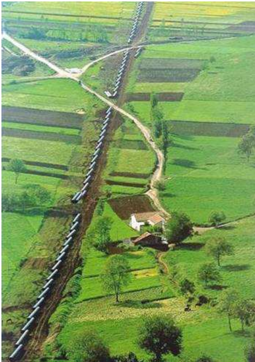
Fig. 5.2 - Sfilamento dei tubi lungo la linea.
