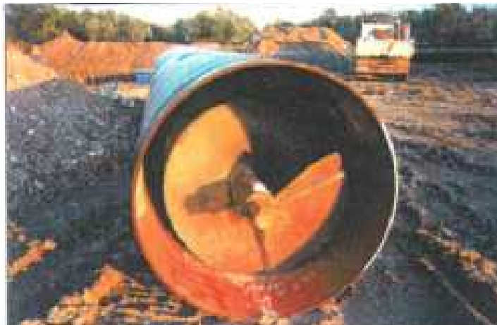
Fig. 5.9 - Coclea per trivella spingitubo.
