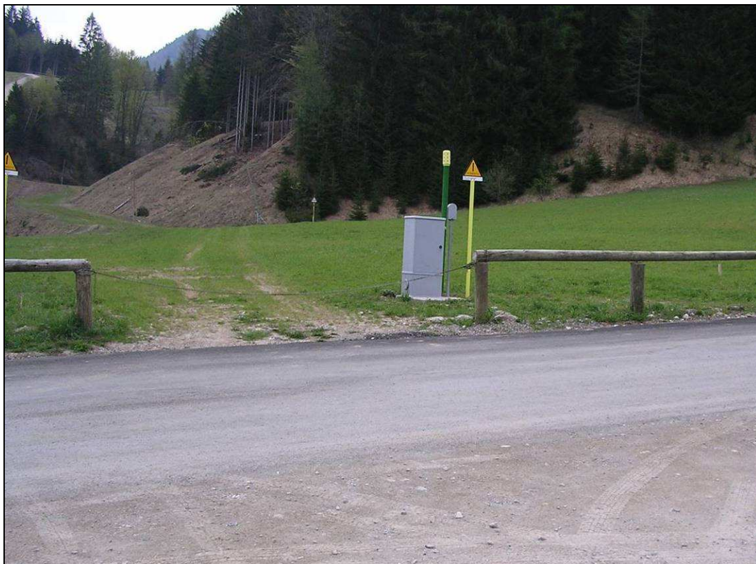
Fig. 9.1 - I cartelli segnalatori del metanodotto ed i tubi di sfiato posti in corrispondenza degli attraversamenti eseguiti con tubo di protezione.
