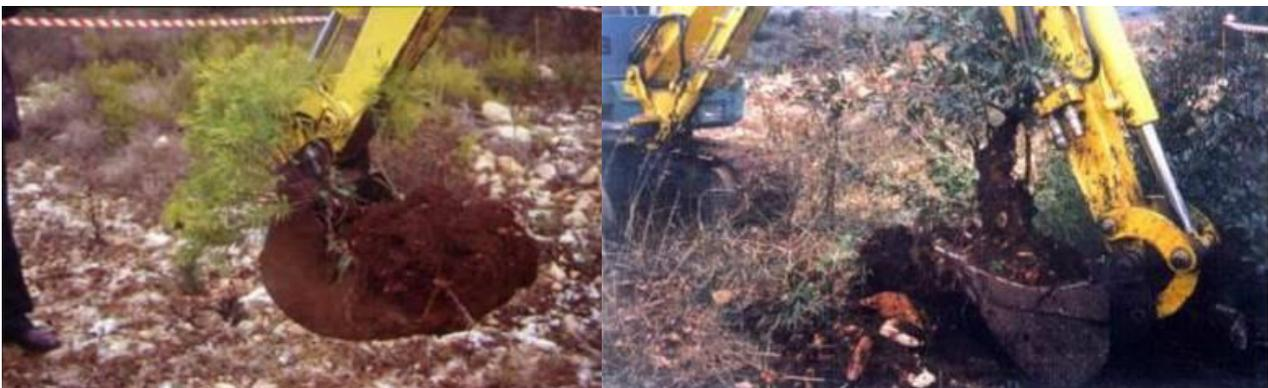
**Fig. 5.11 - Trapianto di arbusti sul Metanodotto Bernalda – Brindisi, Loc. Massafra. Fonte: “Interventi di mitigazione a verde con tecniche di ingegneria naturalistica nel settore delle condotte interrato”, ISPRA 2015).**
