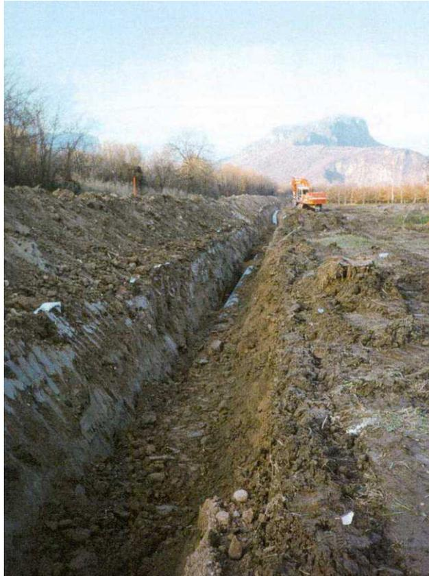
**Fig. 2.9 - Operazione di rinterro della condotta.**
