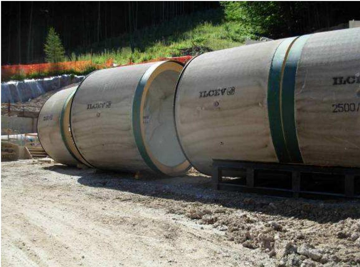
**Fig. 2.18 - Stoccaggio tubi in c.a.**
