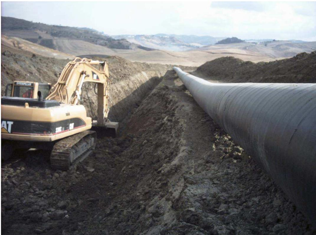
**Fig. 2.7 - Scavo per l'alloggiamento della condotta.**
