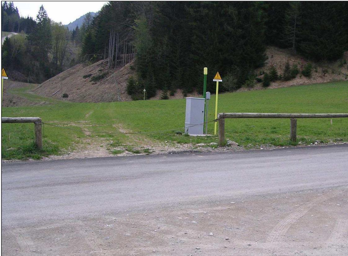
**Fig. 2.21 - I cartelli segnalatori del metanodotto ed i tubi di sfiato posti in corrispondenza degli attraversamenti eseguiti con tubo di protezione.**
