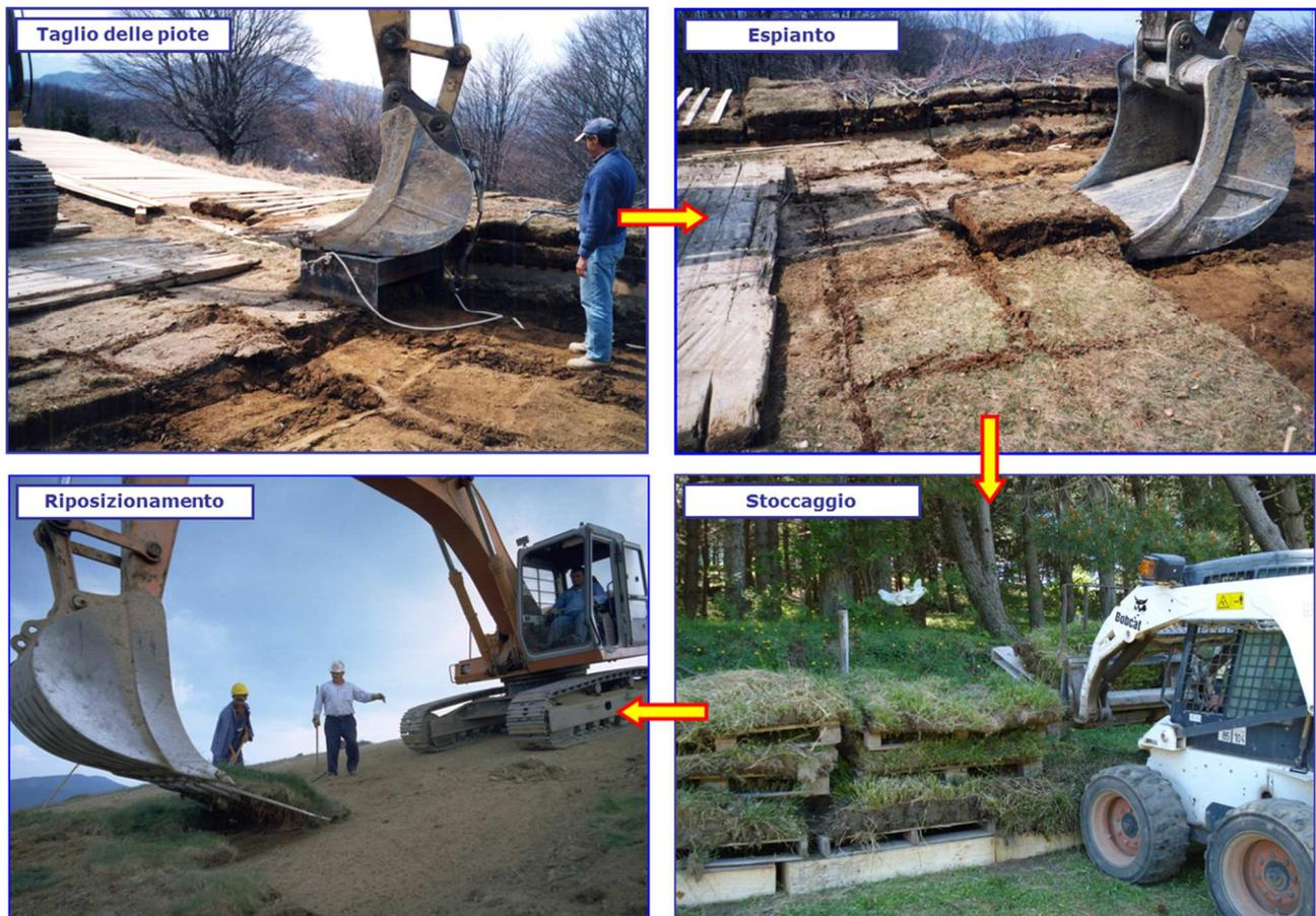
**Fig. 4.9 - Fasi di taglio, espanto, conservazione e riposizionamento di zolle.**
