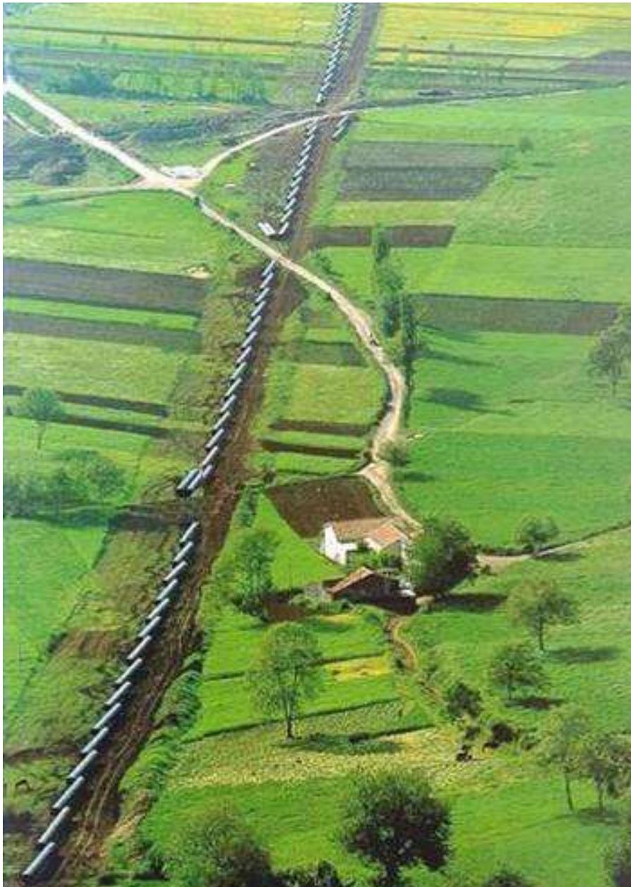
**Fig. 2.5 - Sfilamento dei tubi lungo la linea.**
