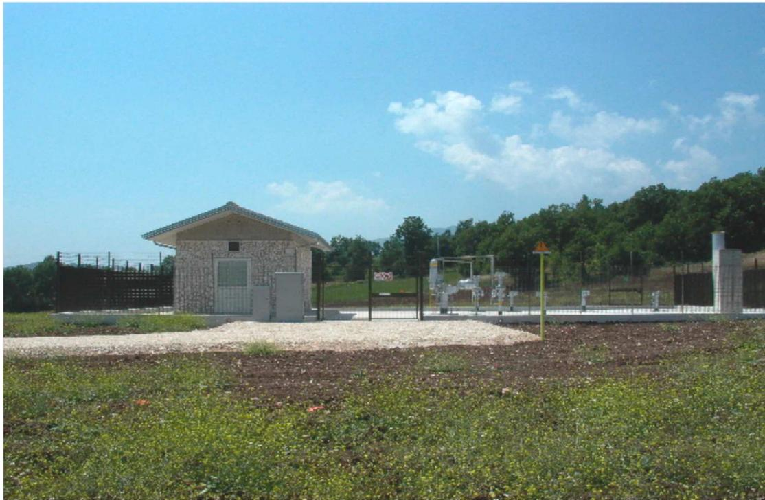
**Fig. 2.22 - Punto di Intercettazione di linea (PIL).**
