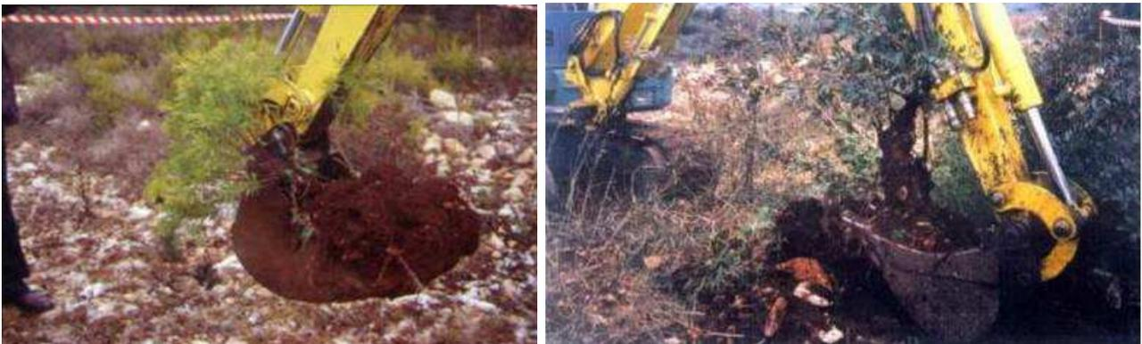
**Fig. 4.10 - Trapianto di arbusti sul Metanodotto Bernalda – Brindisi, Loc. Massafra. Fonte: “Interventi di mitigazione a verde con tecniche di ingegneria naturalistica nel settore delle condotte interrate”, ISPRA 2015).**
