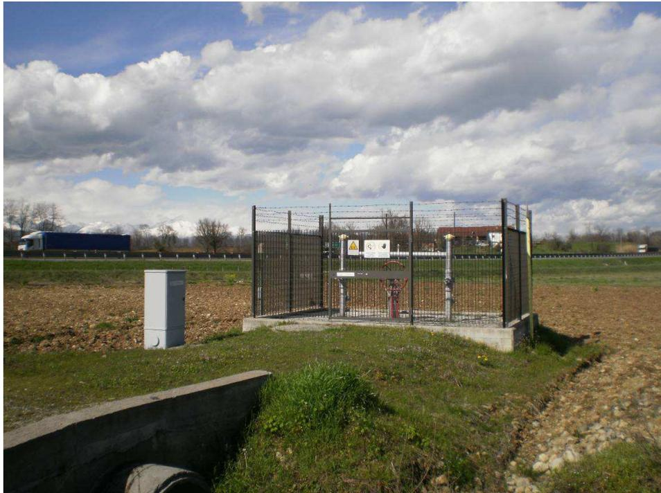
**Fig.5.3 - Esempio di impianto di intercettazione di linea PIL.**
