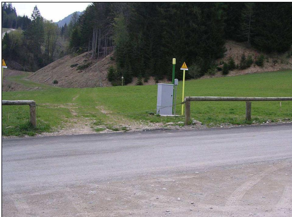
**Fig.5.4 - I cartelli segnalatori del metanodotto ed i tubi di sfiato posti in corrispondenza degli attraversamenti eseguiti con tubo di protezione.**
