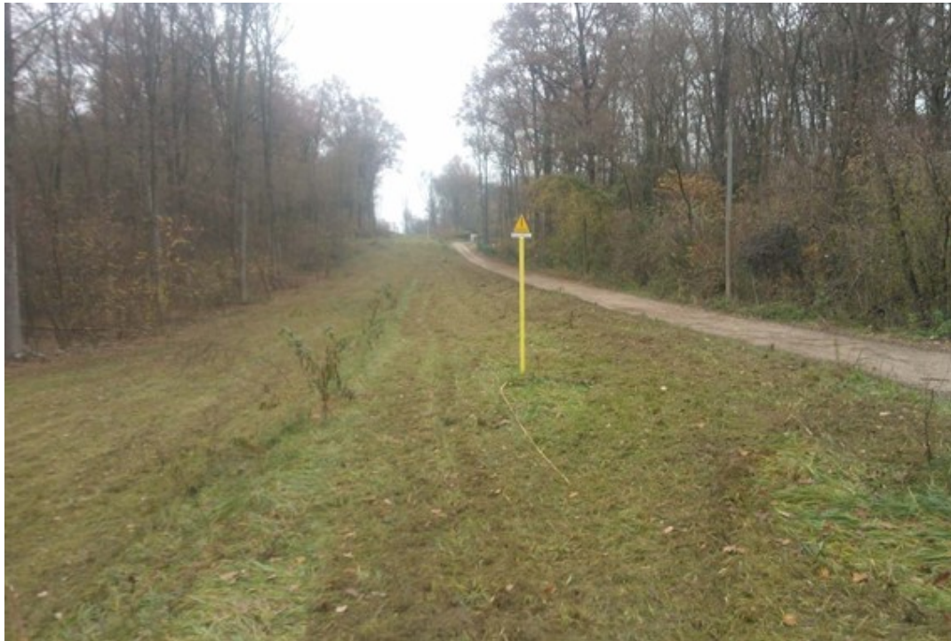
Fig. 4.20 - Ripristino area boscata igrofile nel Parco del Ticino (Metanodotto Somma Lombardo – Besnate): situazione dopo gli inerbimenti.
