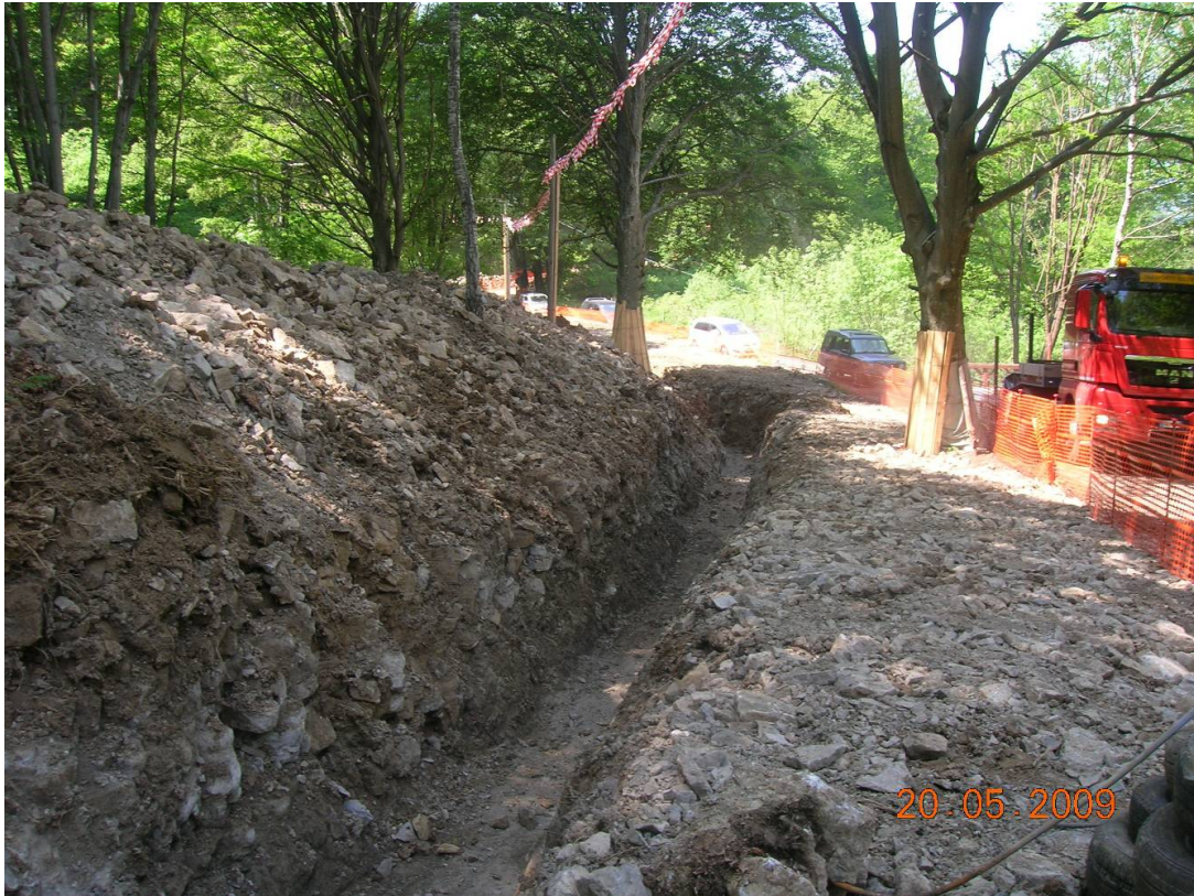
Fig. 4.26 - Esempio di protezione del fusto in fase di cantiere.
