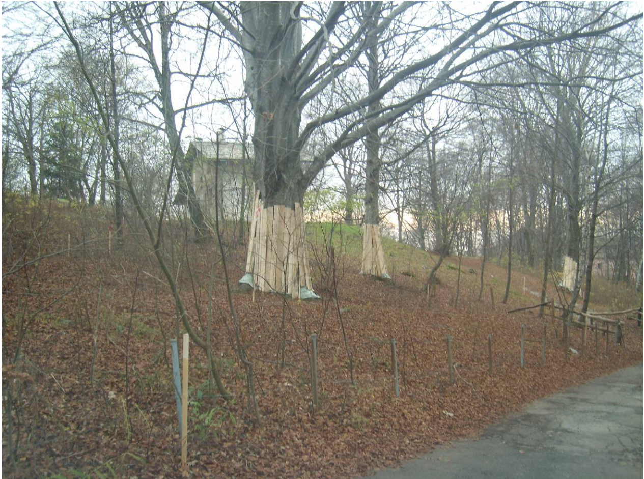
Fig. 4.25 - Salvaguardia piante prima dei lavori.
