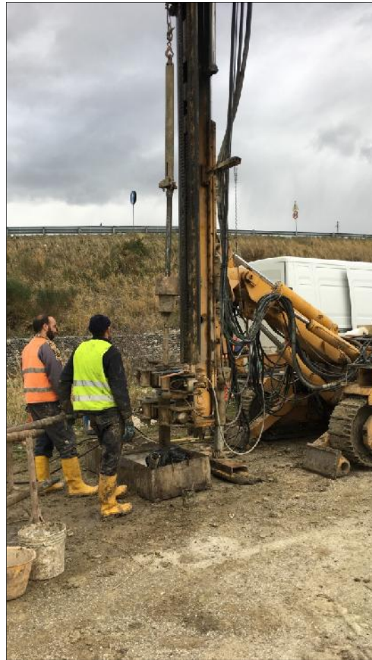
Esecuzione SPT in S28
