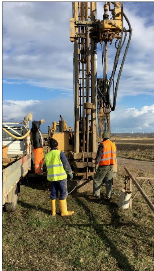
Esecuzione SPT in S57
