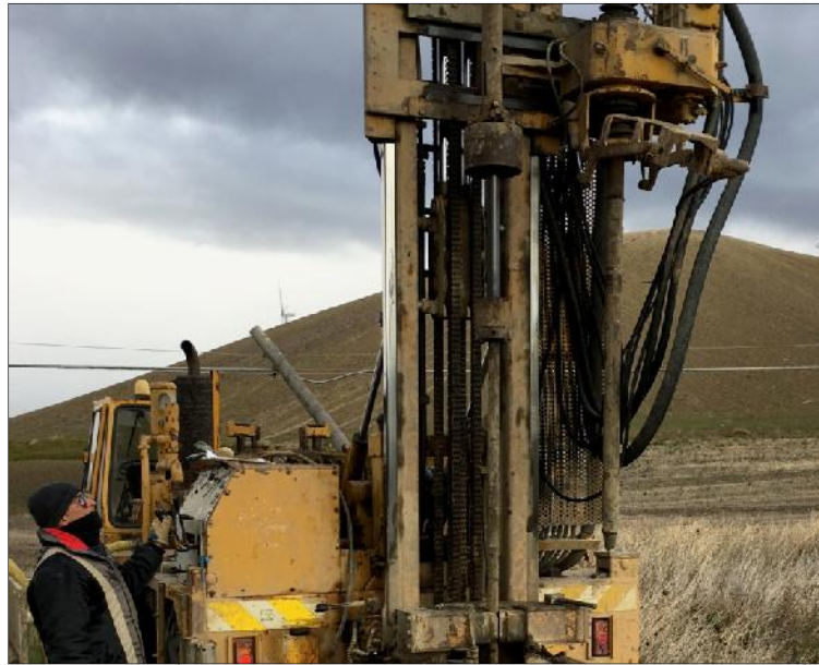
Esecuzione SPT in S58
