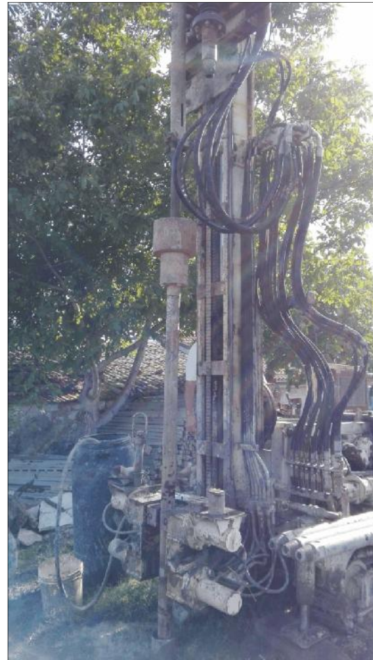
Esecuzione SPT in S13
