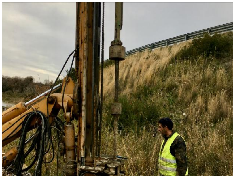
Esecuzione SPT in S29
