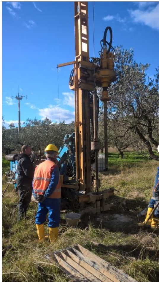
Esecuzione SPT in S6
