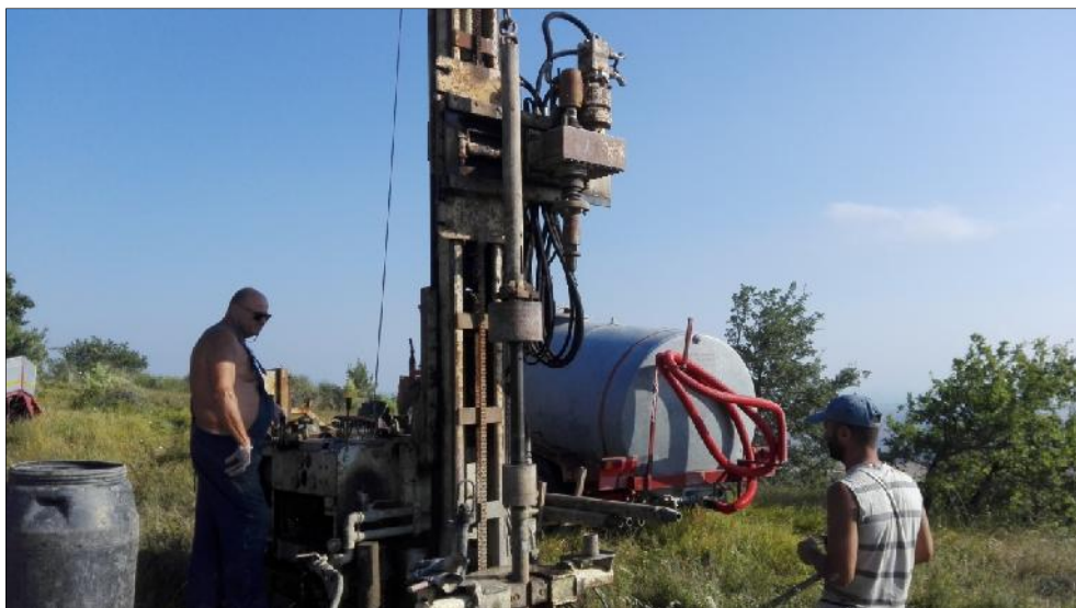
Esecuzione SPT in S5v
