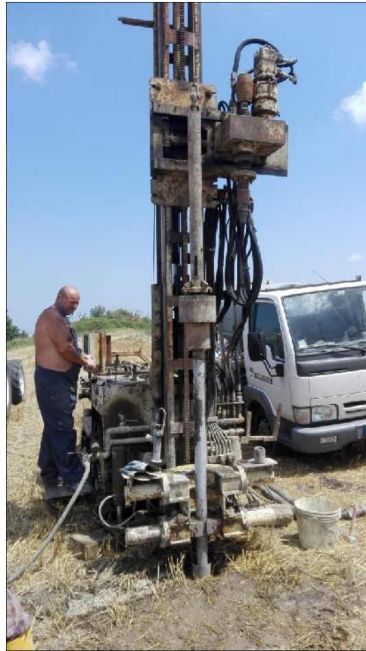
Esecuzione SPT in S4v
