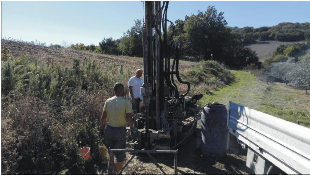
Esecuzione SPT in S16
