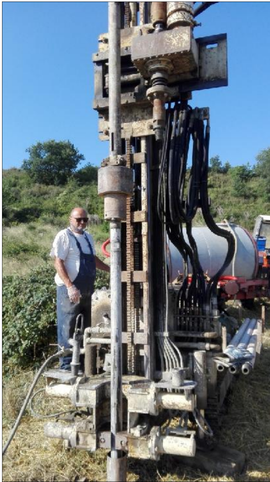
Esecuzione SPT in S3v
