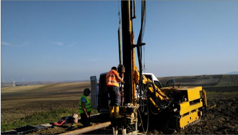
Esecuzione SPT in S15v
