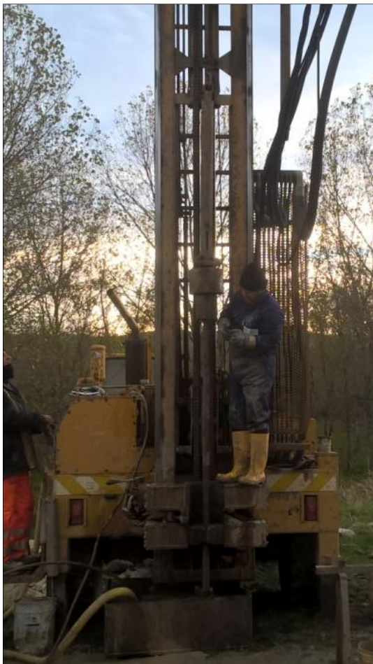
Esecuzione SPT in S53
