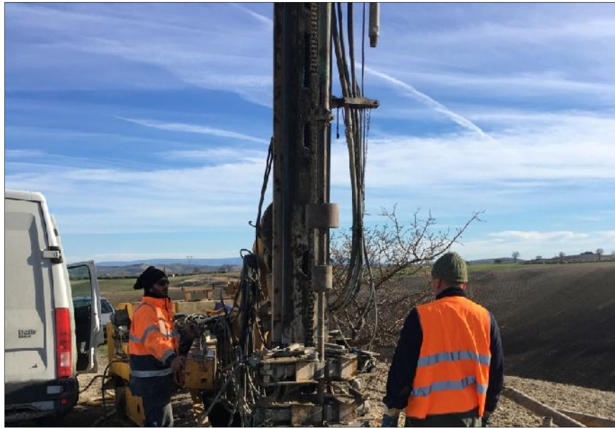
Esecuzione SPT in S44
