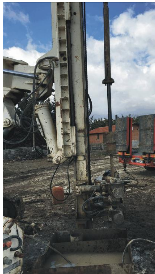
Esecuzione SPT in S43
