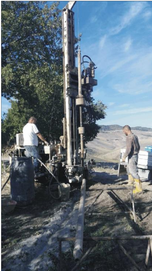
Esecuzione SPT in S11
