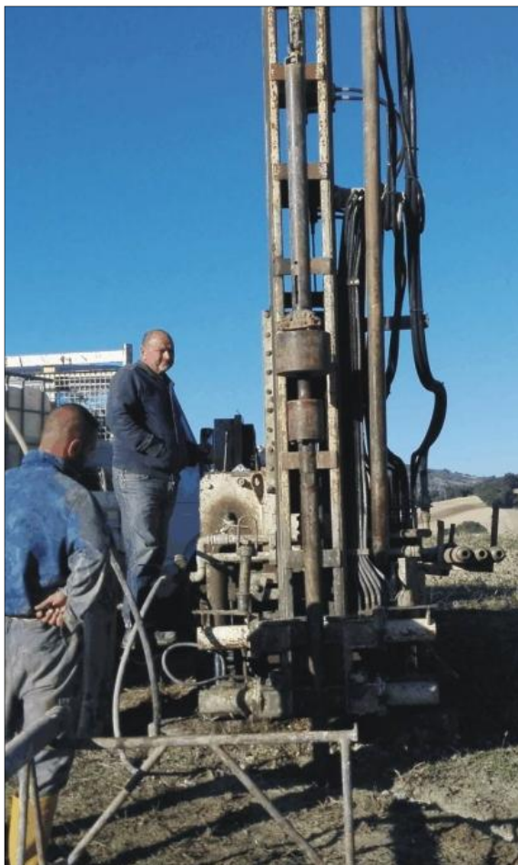
Esecuzione SPT in S18
