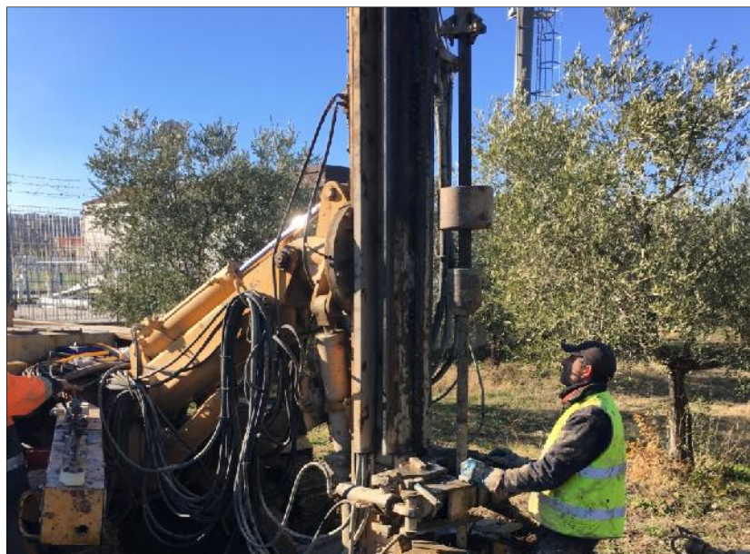
Esecuzione SPT in S34
