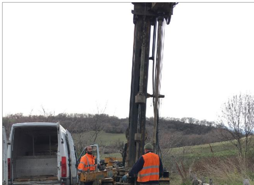
Esecuzione SPT in S15
