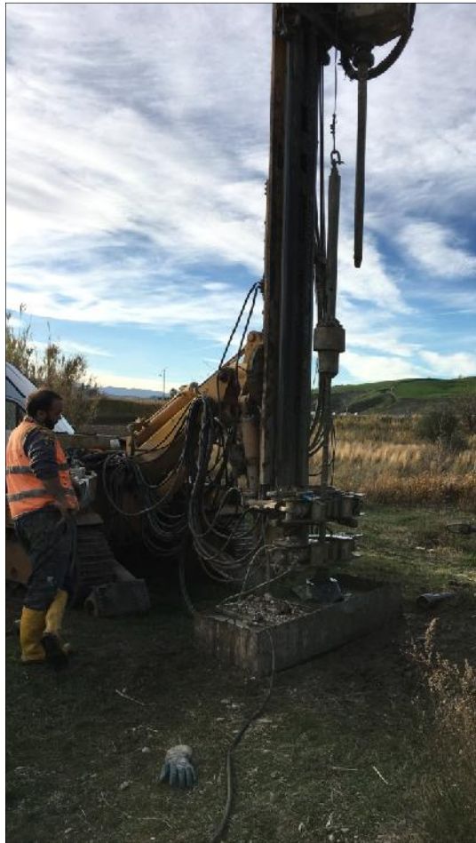
Esecuzione SPT in S27
