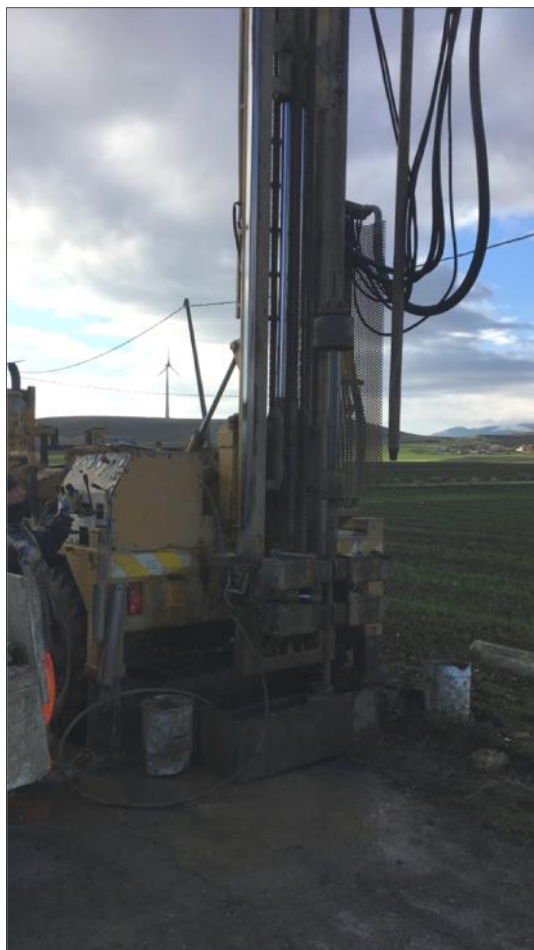
Esecuzione SPT in S59
