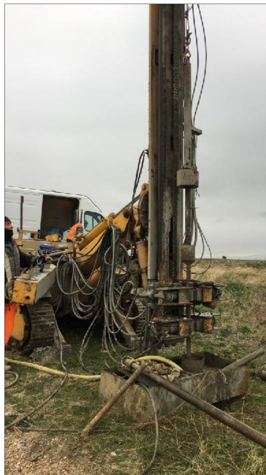
Esecuzione SPT in S60
