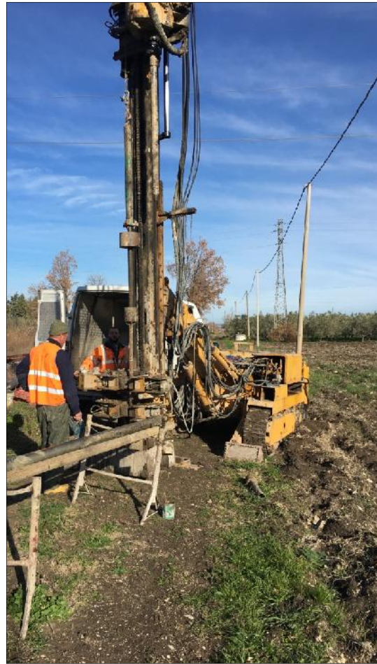
Esecuzione SPT in S33
