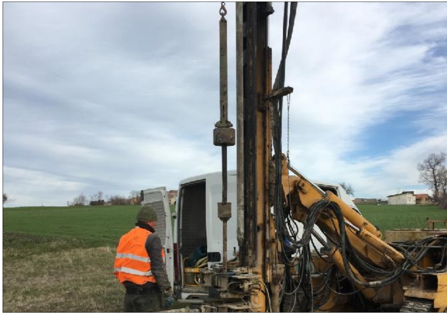
Esecuzione SPT in S20
