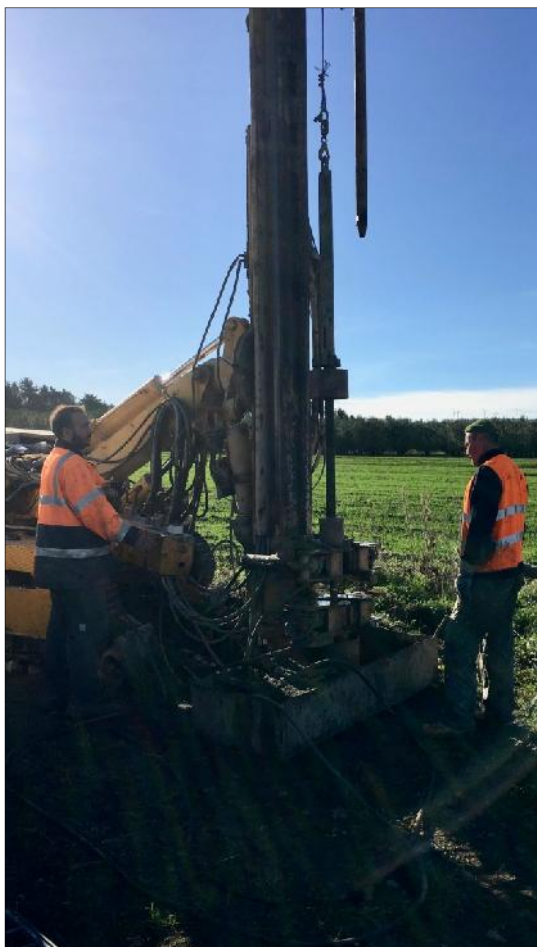
Esecuzione SPT in S36
