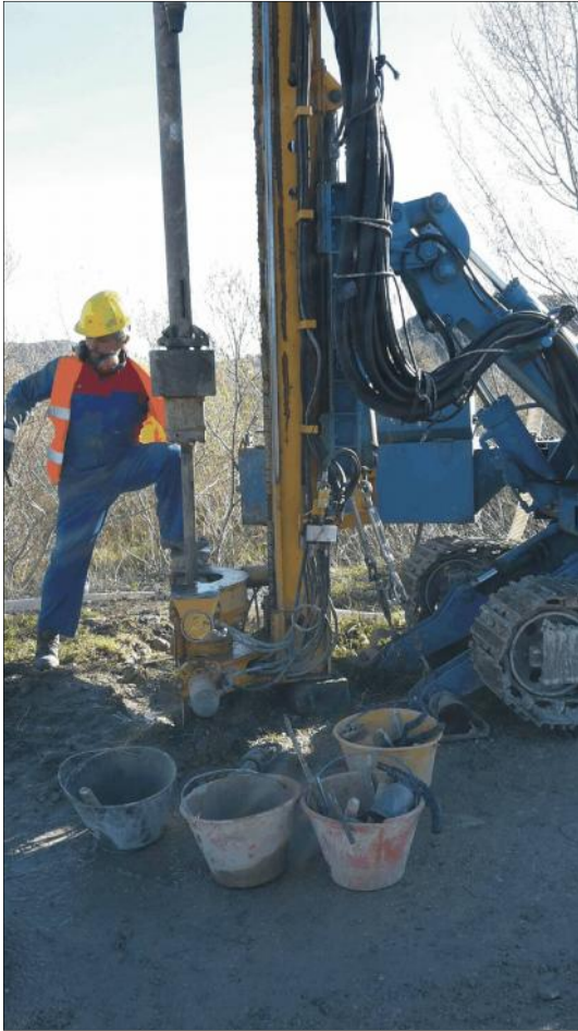
Esecuzione SPT in S3
