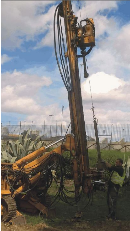
Esecuzione SPT in S1
