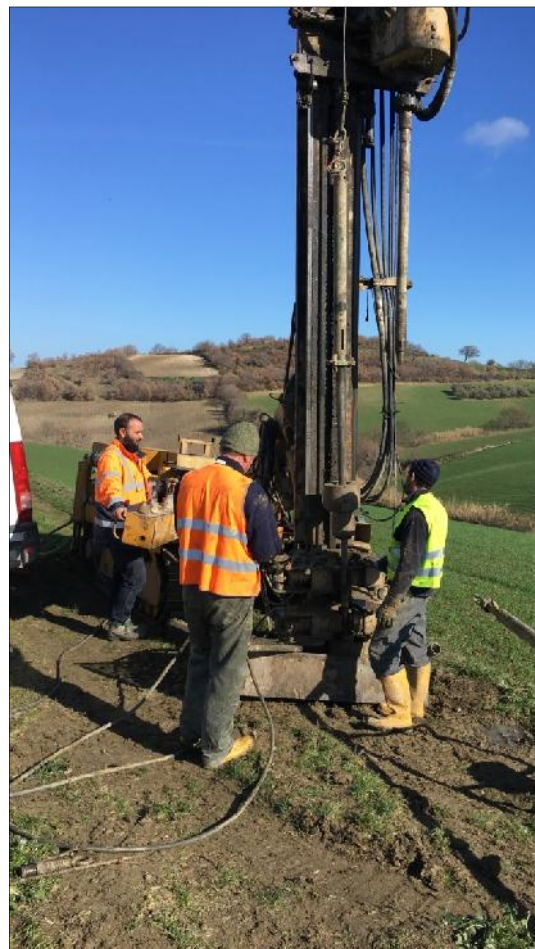
Esecuzione SPT in S19
