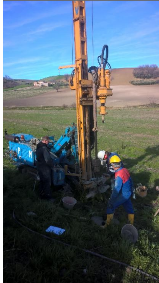
Esecuzione SPT in S1a
