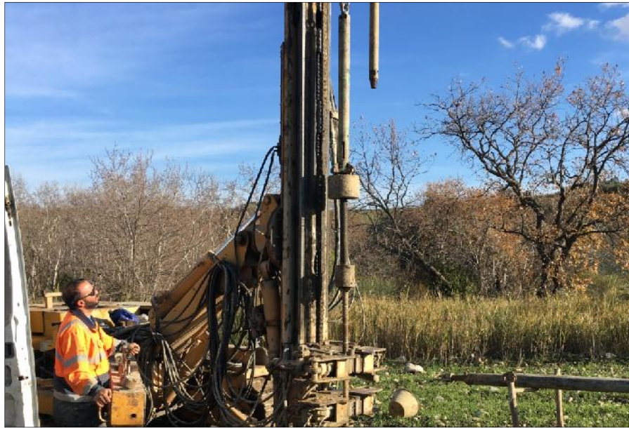
Esecuzione SPT in S35
