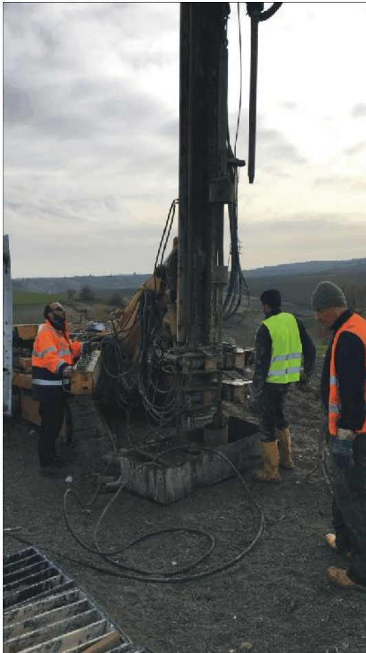
Esecuzione SPT in S31
