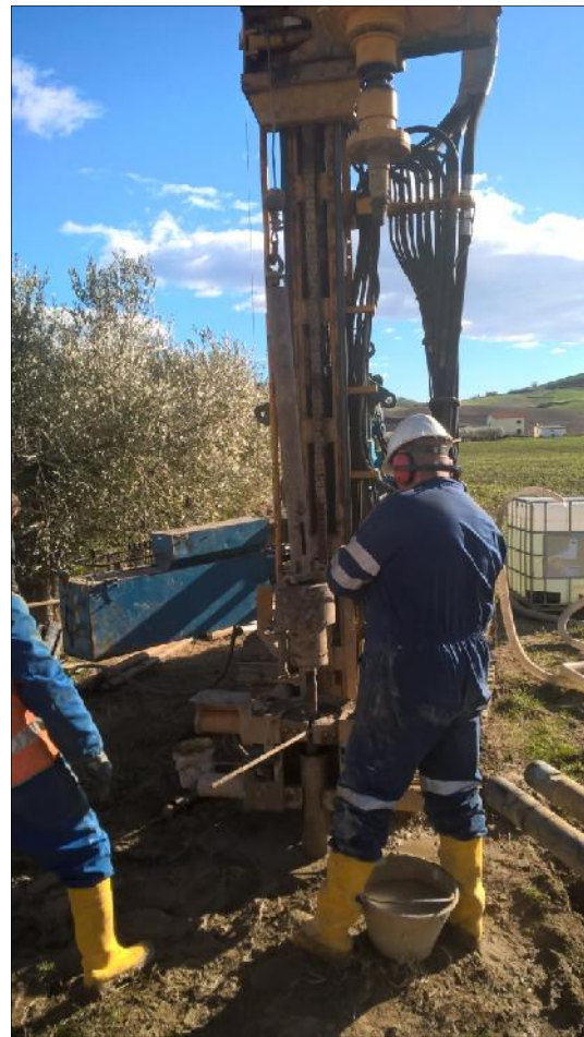
Esecuzione SPT in S8
