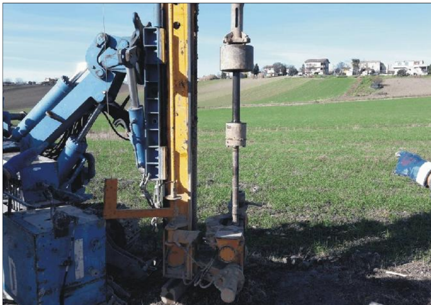
Esecuzione SPT in S2
