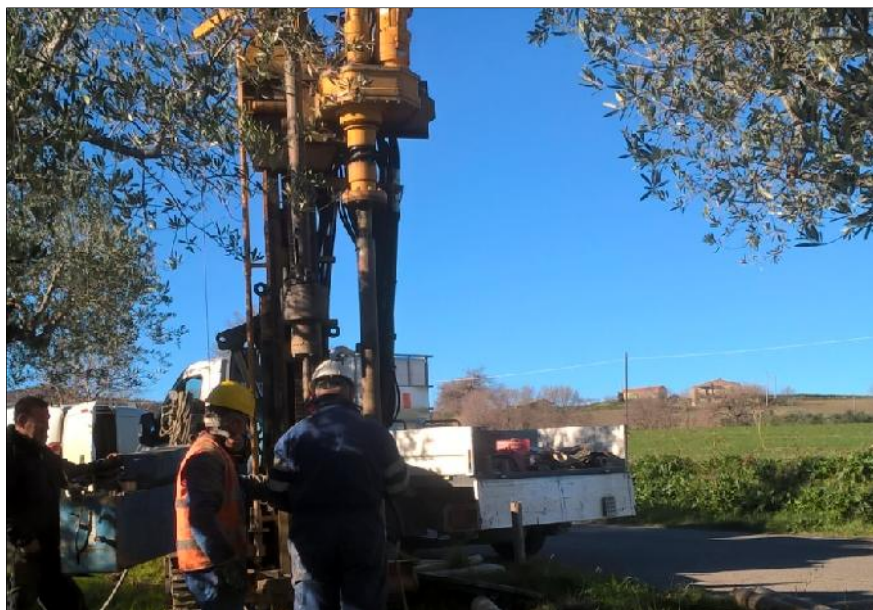
Esecuzione SPT in S9
