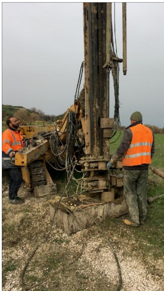
Esecuzione SPT in S21
