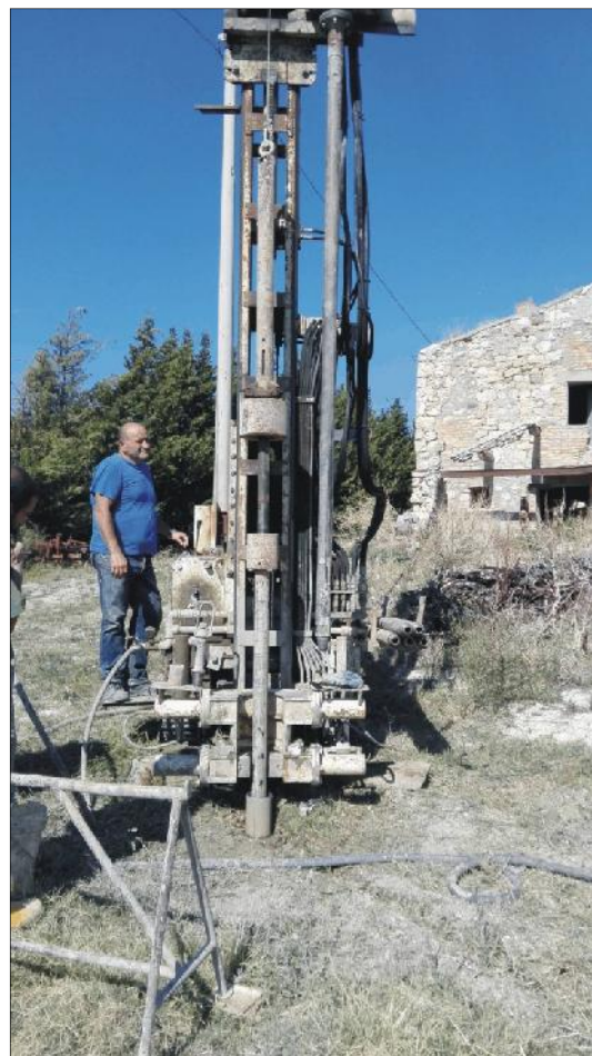
Esecuzione SPT in S22
