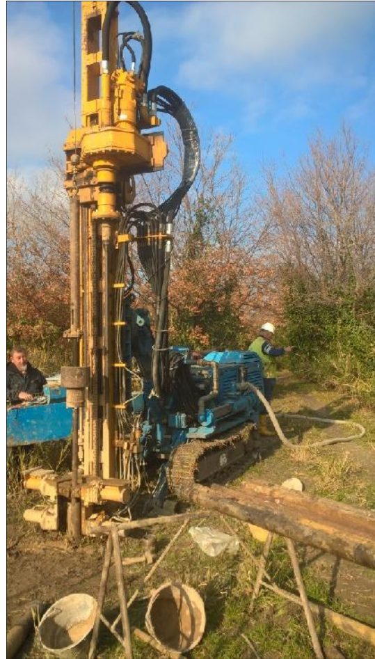
Esecuzione SPT in S4
