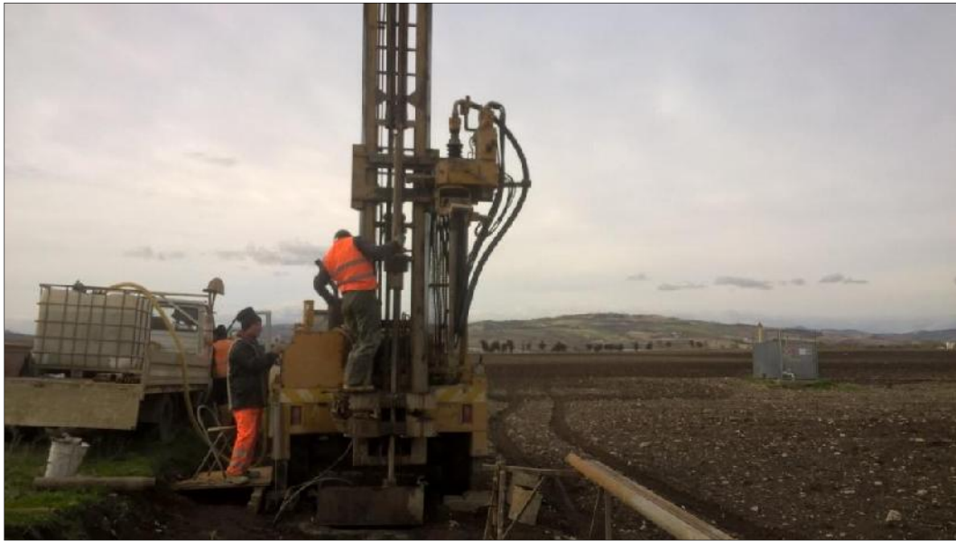
Esecuzione SPT in S49
