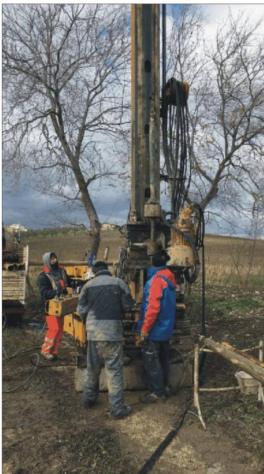
Esecuzione SPT in S45
