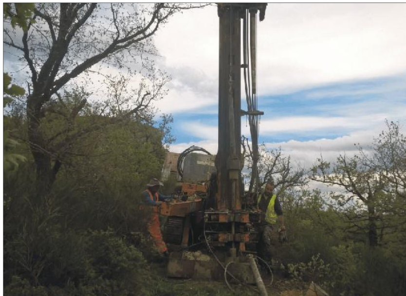
Esecuzione SPT in S5
