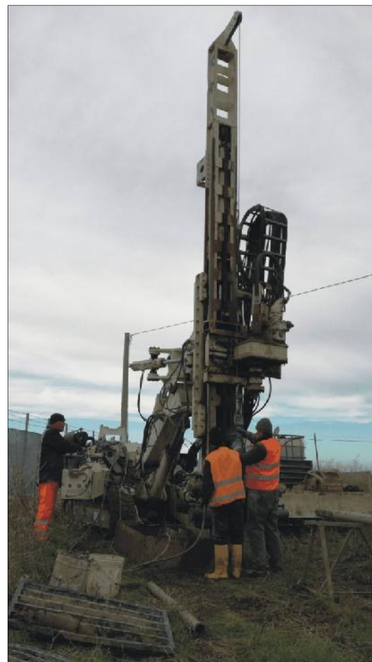
Esecuzione SPT in S48
