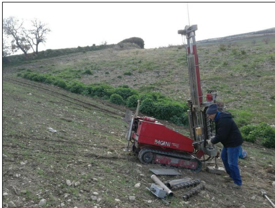
Foto postazione DPSH13
