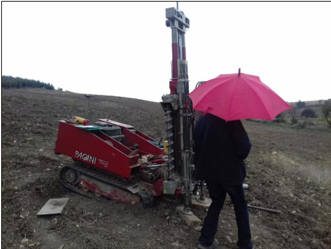
Foto postazione DPSH16
