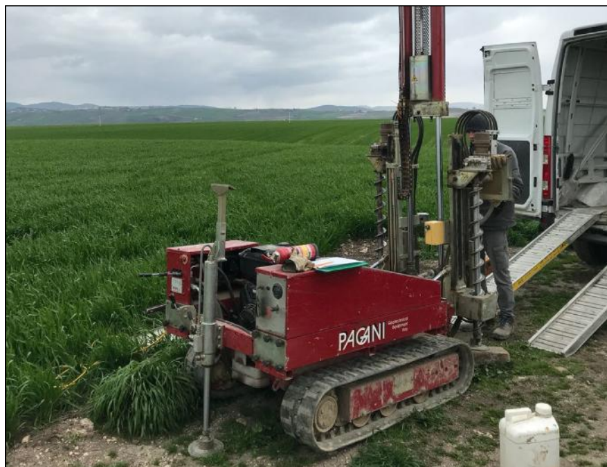
Foto postazione DPSH23
