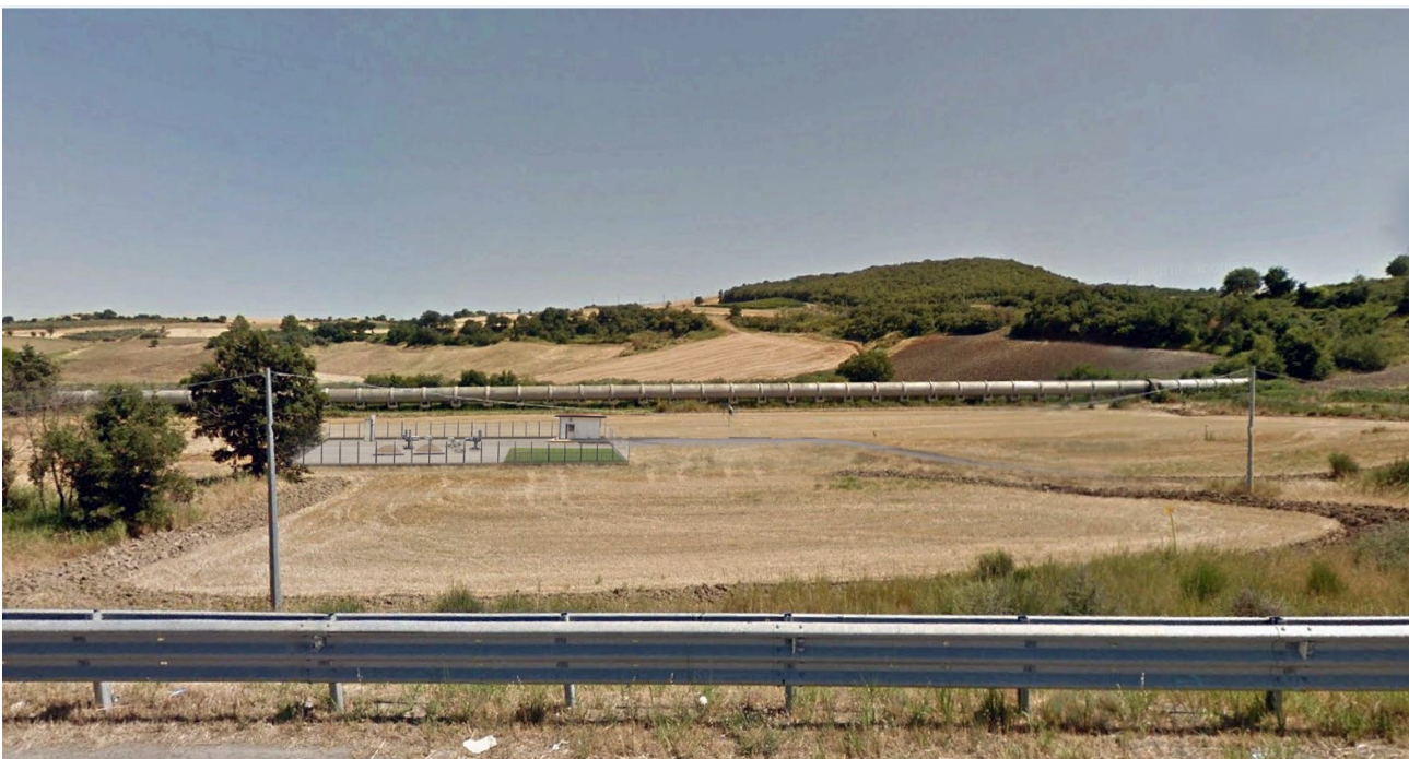
Fig. 3.7 – Area di realizzazione del PIDI n.6 in aree agricole classificate "Aree Pae - aree con prevalenza di elementi di interesse produttivo-agricolo di valore eccezionale"(PTPAAV_2), nel comune di Larino, km 29+195 circa: opera ultimata.
