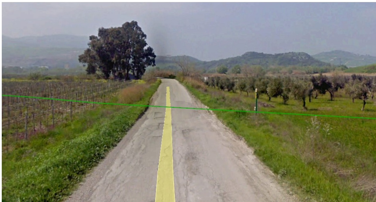
Fig. 2.2 – Interferenza tracciato in rimozione “Allacciamento Calbon DN80 (3”), MOP 64 bar” con strada comunale classificata A2C nel comune di Montenero di Bisaccia.
