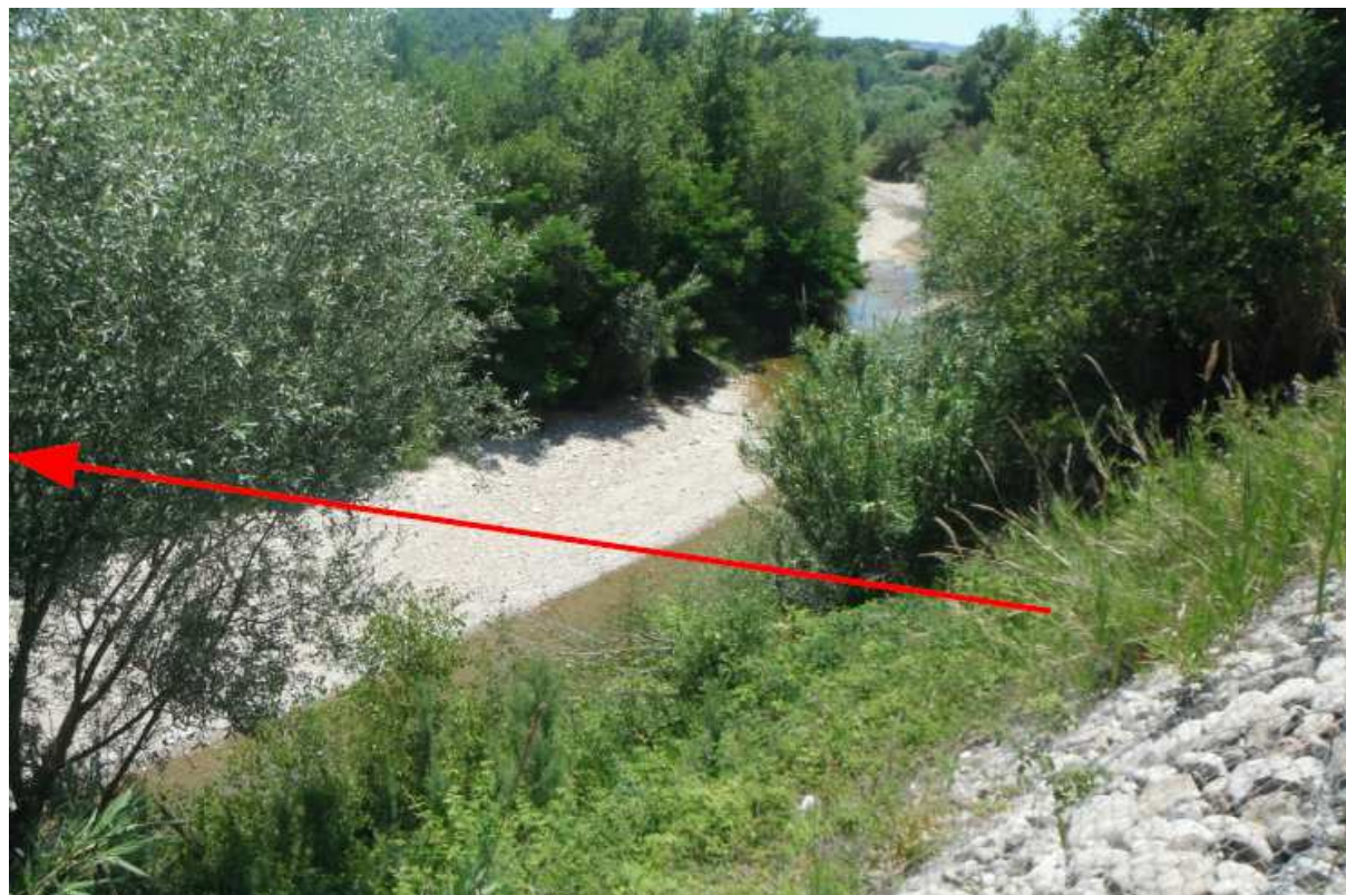
Figura 3: immagine fotografica del punto d'attraversamento del Fiume Treste
