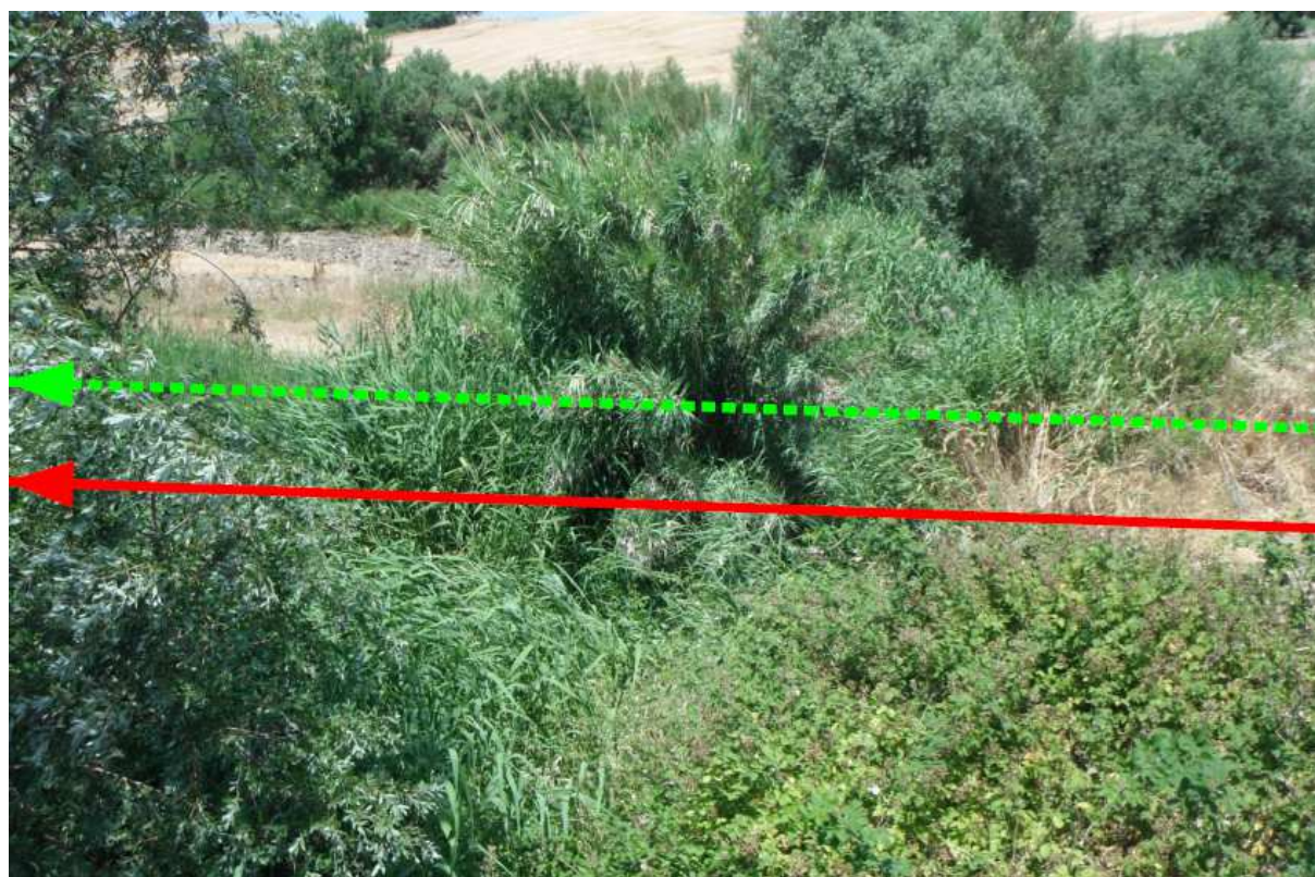
Figura 3: immagine fotografica del punto d'attraversamento del Torrente Saccione
