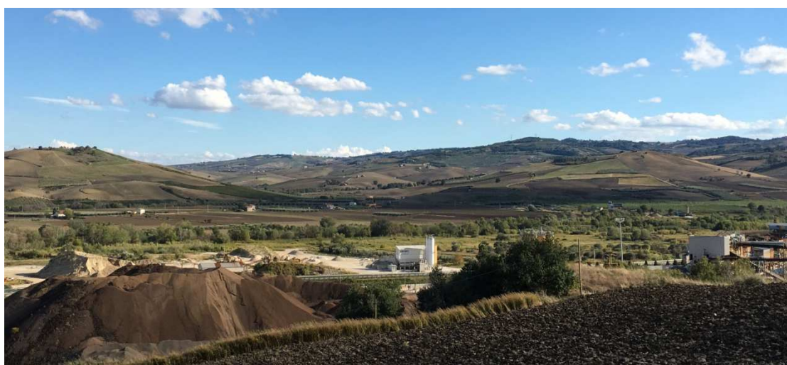
Figura 7.1-7 - Panoramica dei versanti sulla valle del Trigno con argille di Montesecco (COS), vista da SE - vicino progressiva km 4+100
