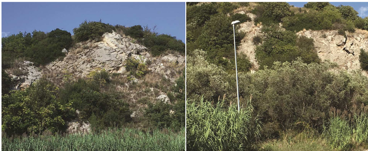
Figura 7.1-3 - Affioramenti di gessi (LPS) presso i fondovalle dei F. Trigno e F. Treste - vicino progressiva km 4+300.
