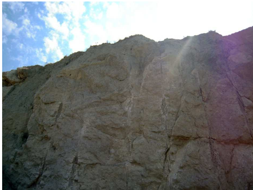
Figura 7.1-2 - Affioramento di gessi (LPS) presso cava di Montenero di Bisaccia, sx idrografica del F. Trigno - vicino progressiva km 4+500.
