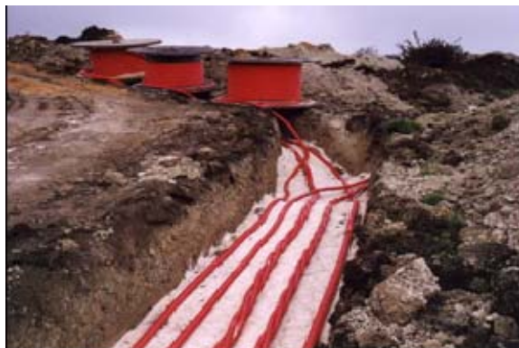
Figura 1 – Posa dei cavidotti interrati
