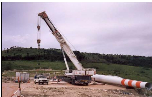
Figura 2 – autogru di montaggio
