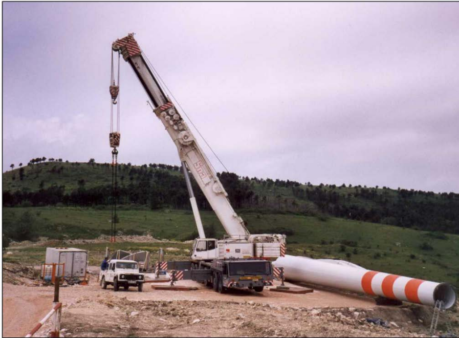
Figura 1.4.6.-1.: Fase di montaggio di un aerogeneratore.
