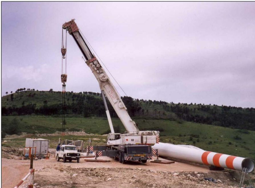
Figura 1.4.6.-1.: Fase di montaggio di un aerogeneratore.
