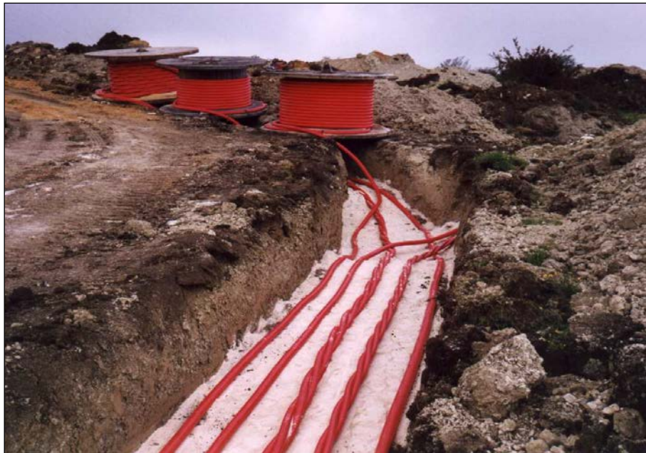
Figura 1.4.7.-1.: Particolare della posa cavi elettrici.
