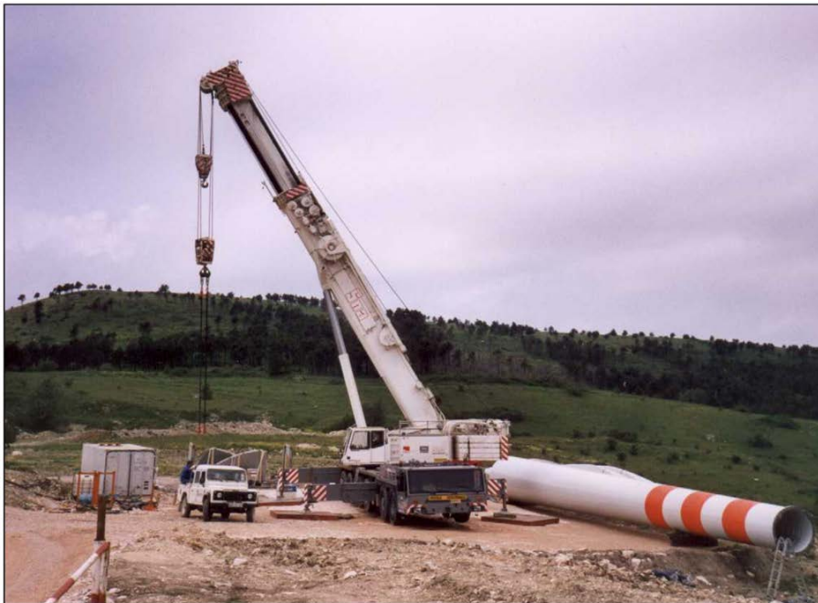
Figura 1.6.6.-1.: Fase di montaggio di un aerogeneratore.
