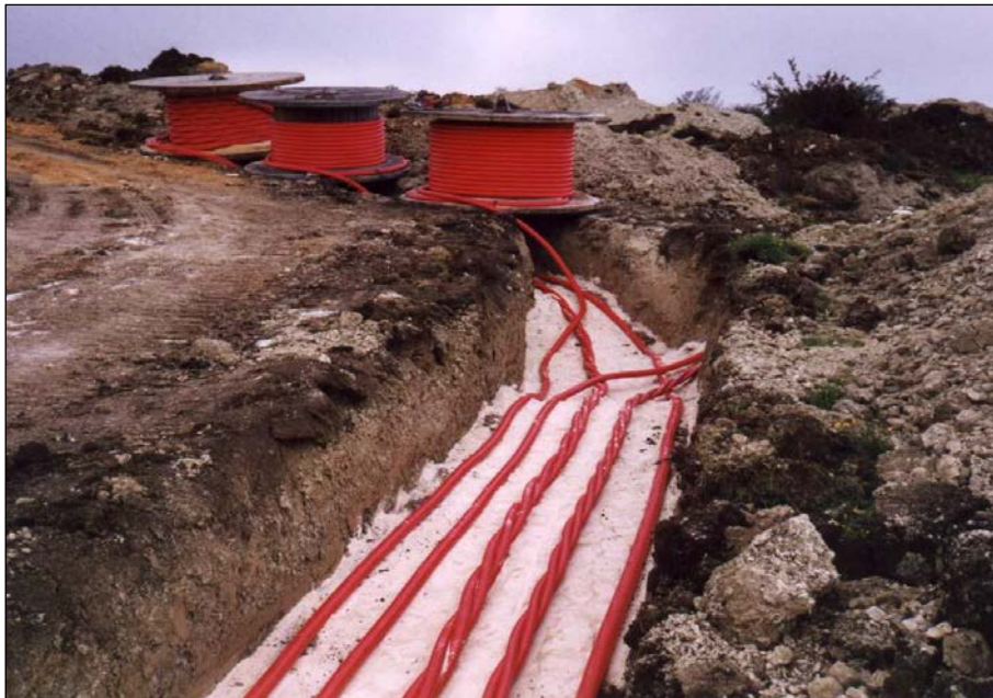
Figura 1.6.7.-1.: Particolare della posa cavi elettrici.
