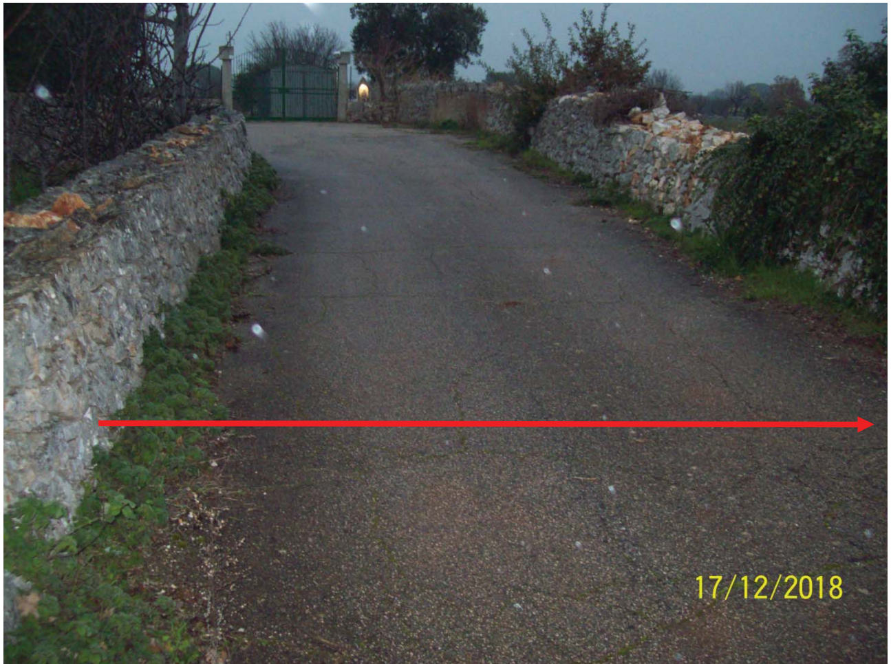
Foto n. 3: Panoramica attraversamento Strada Vicinale Pozzo Priore di Sotto
