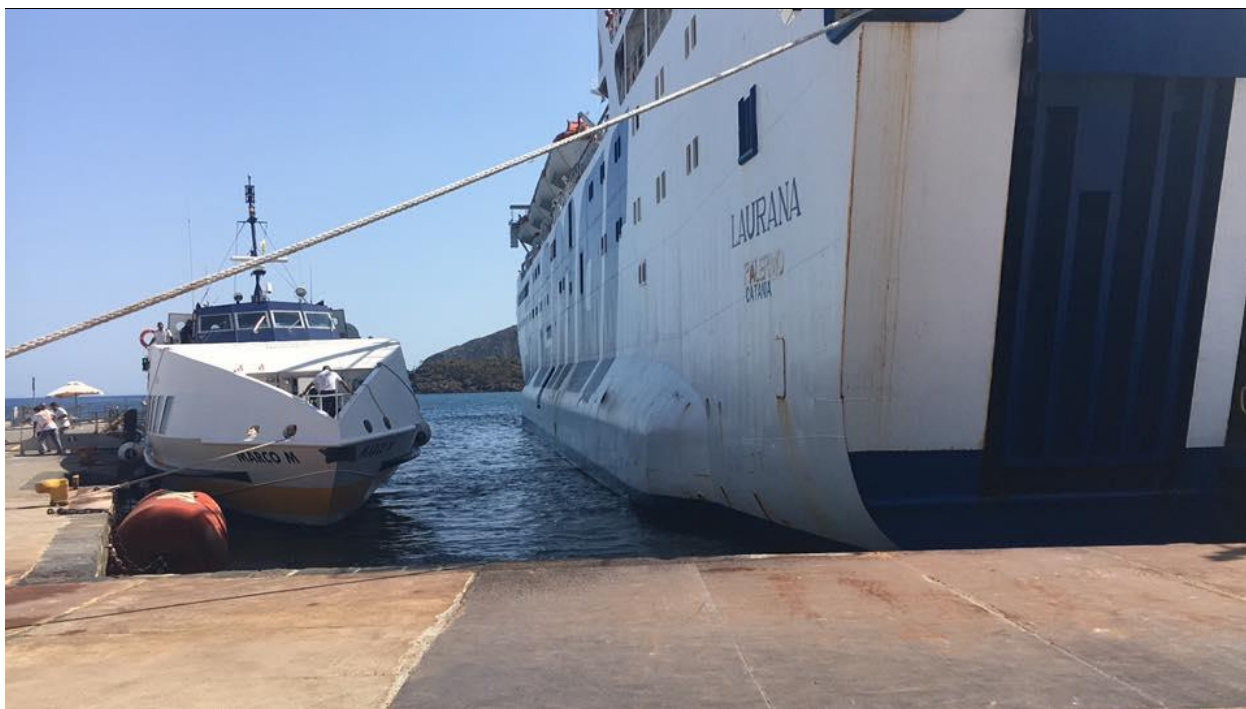
Figura 3.3 Molo e Banchina navi – attracco contemporaneo nave-aliscafo
