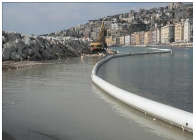
Figura 3-1 – Utilizzo di barriere anti-torbidità durante i lavori
