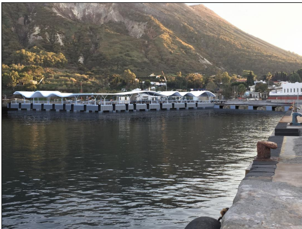
Figura 3-5 – Vista d'insieme del pontile post operam
